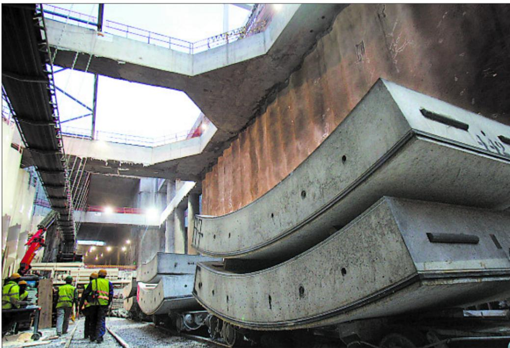
Arriba, tramo del túnel ya perforado. Sobre estas líneas, las enormes dovelas que van formando las paredes. / R. GUTIÉRREZ
