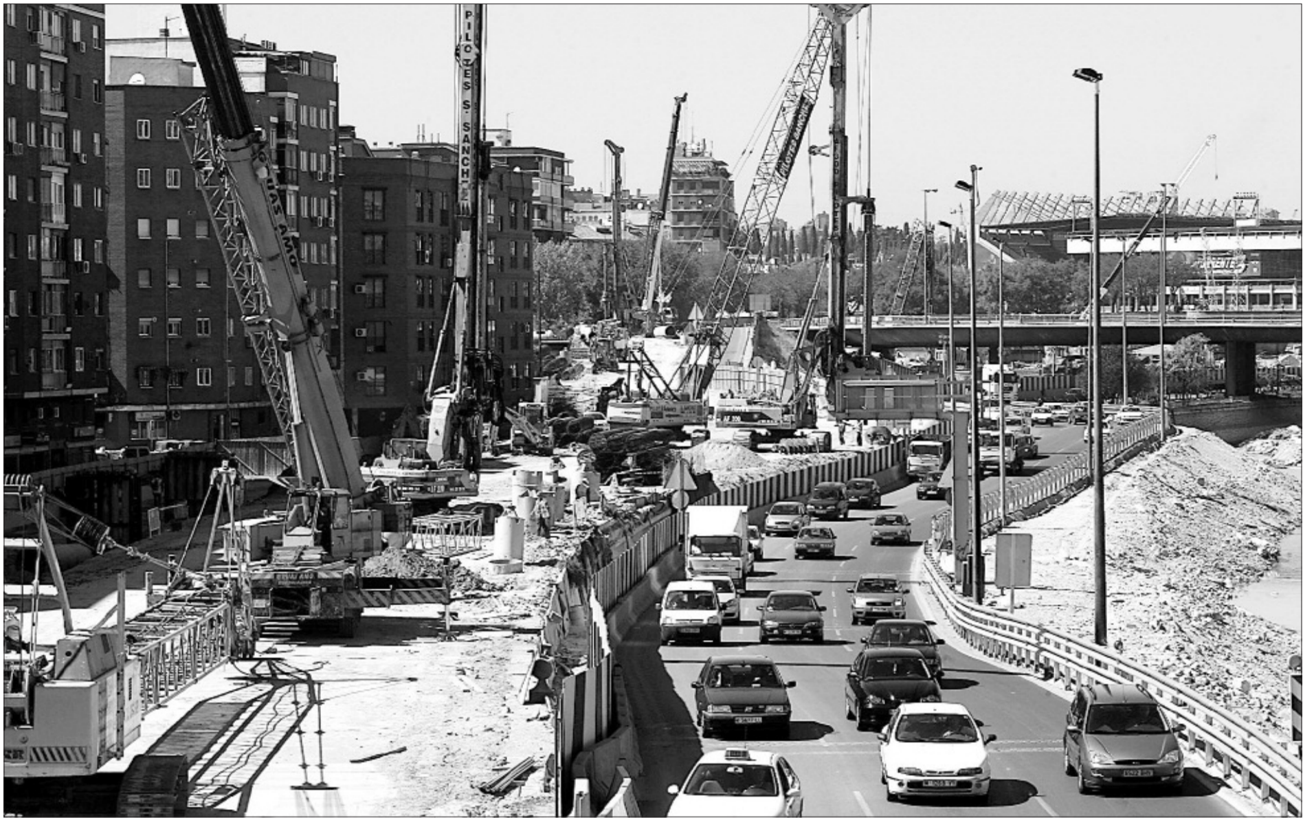
Obra sobre el cauce del río para desviar los coches poco antes de pasar bajo el puente de Praga. A la izquierda, las grúas trabajan sobre la calzada original. / GORKA LEJARCEGI
