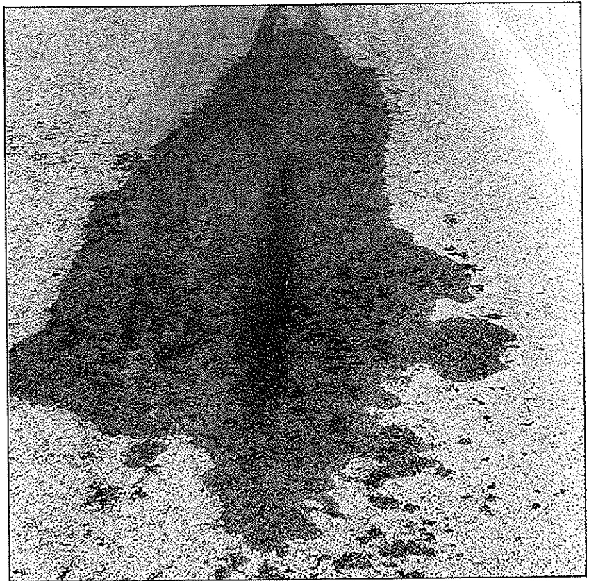
Aparición de zonas húmedas en la superficie.
