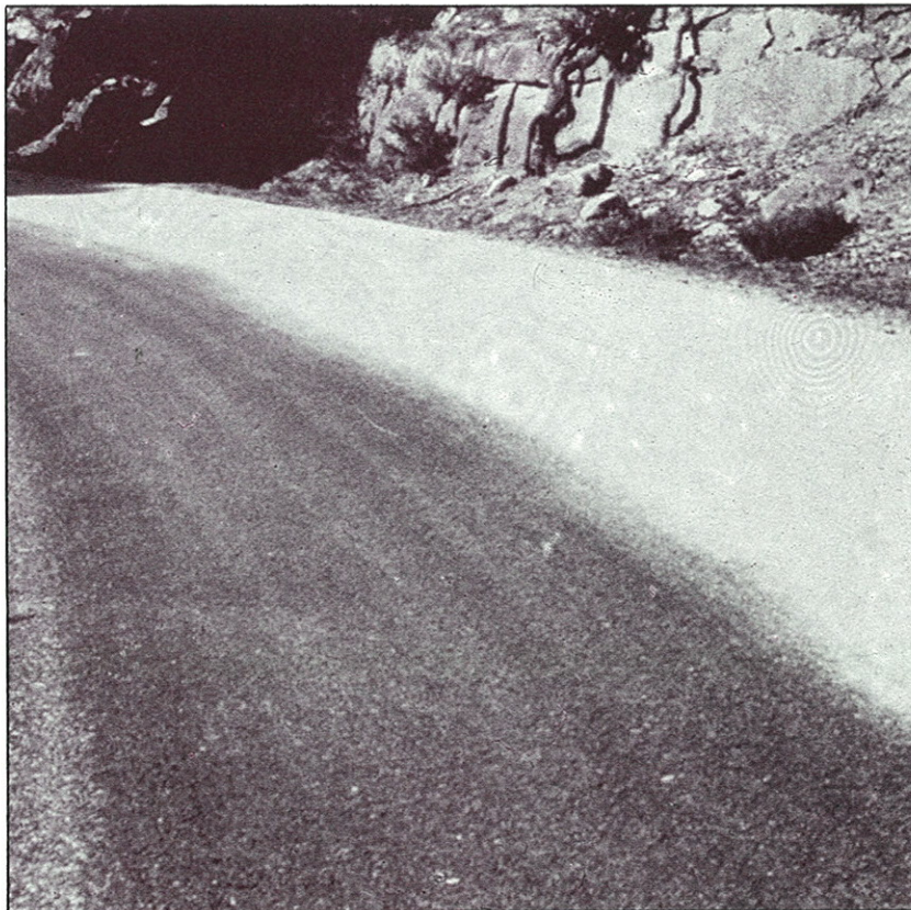
Separación de la película de ligante de los áridos en presencia de humedad.
