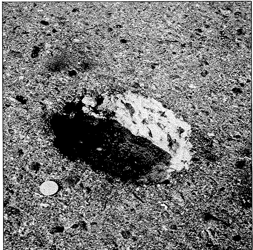
Cavidades producidas en el pavimento y firme de forma irregular y diferentes tamaños.
