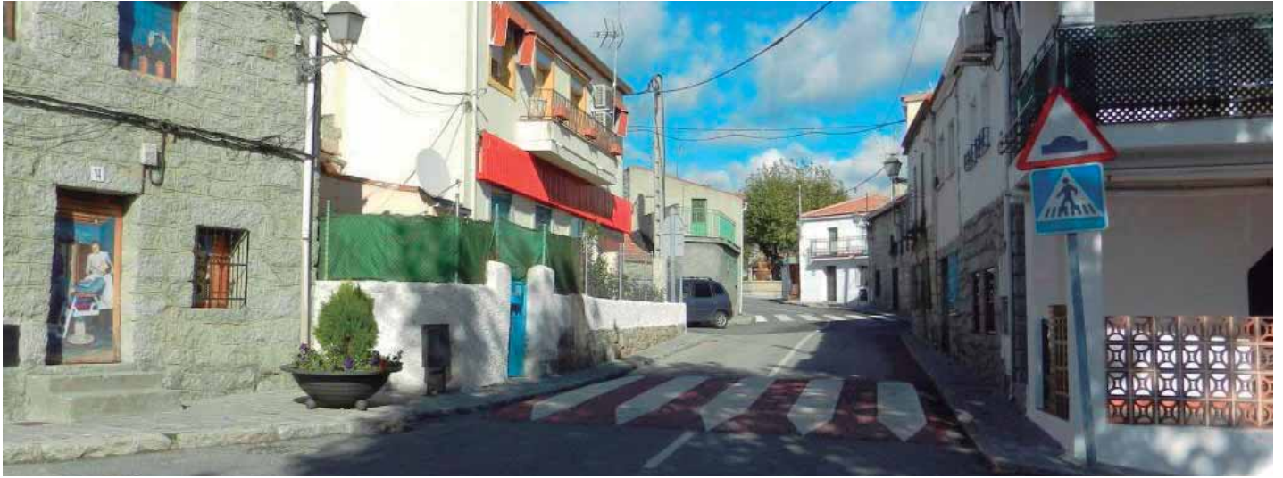
Travesía con reductor de velocidad pero incumpliendo todos los criterios de accesibilidad
