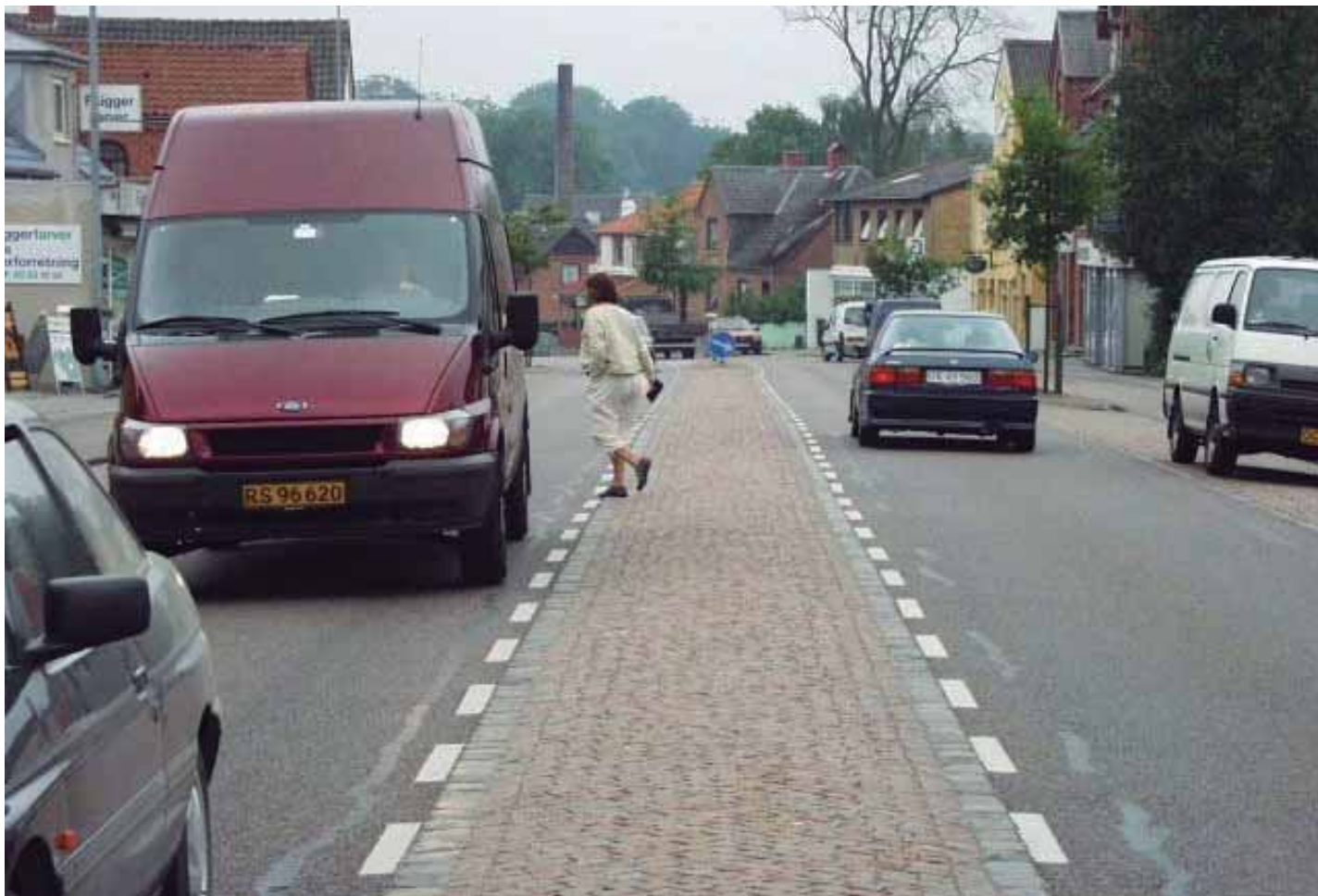
Permeabilización transversal de una travesía en Dinamarca.
