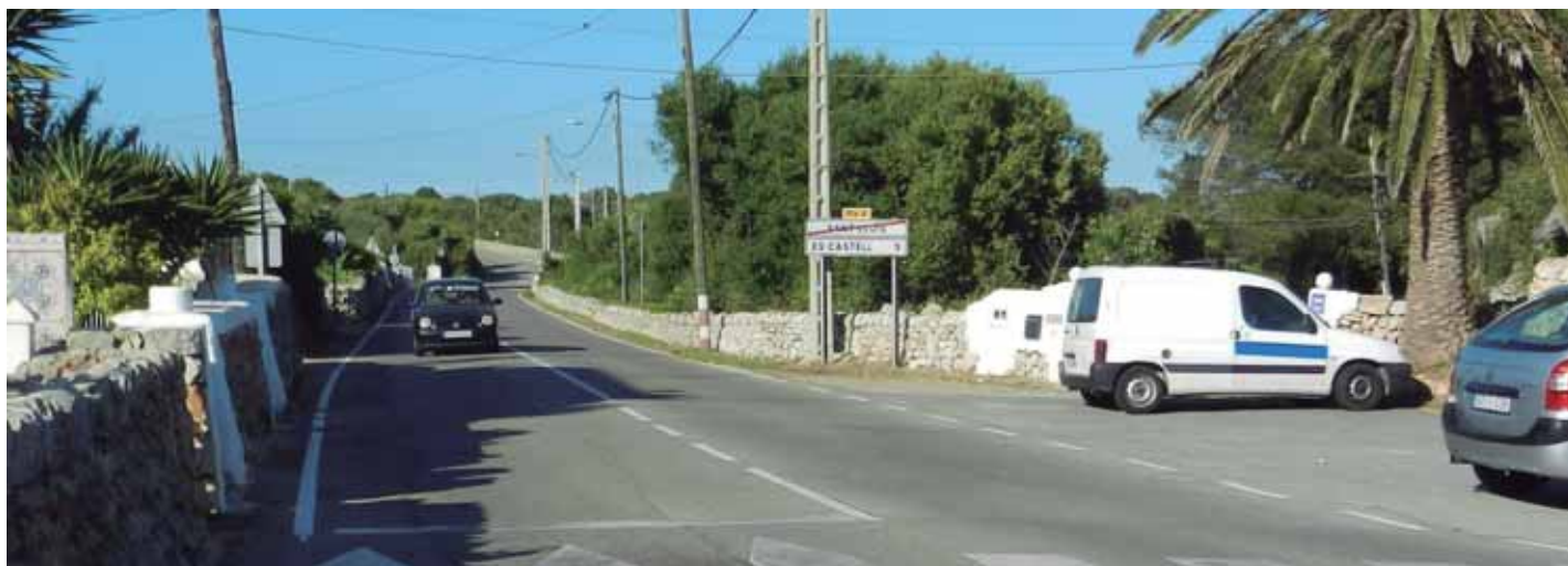
Señal de salida de travesía sin correspondencia con señal de entrada en el otro sentido.
