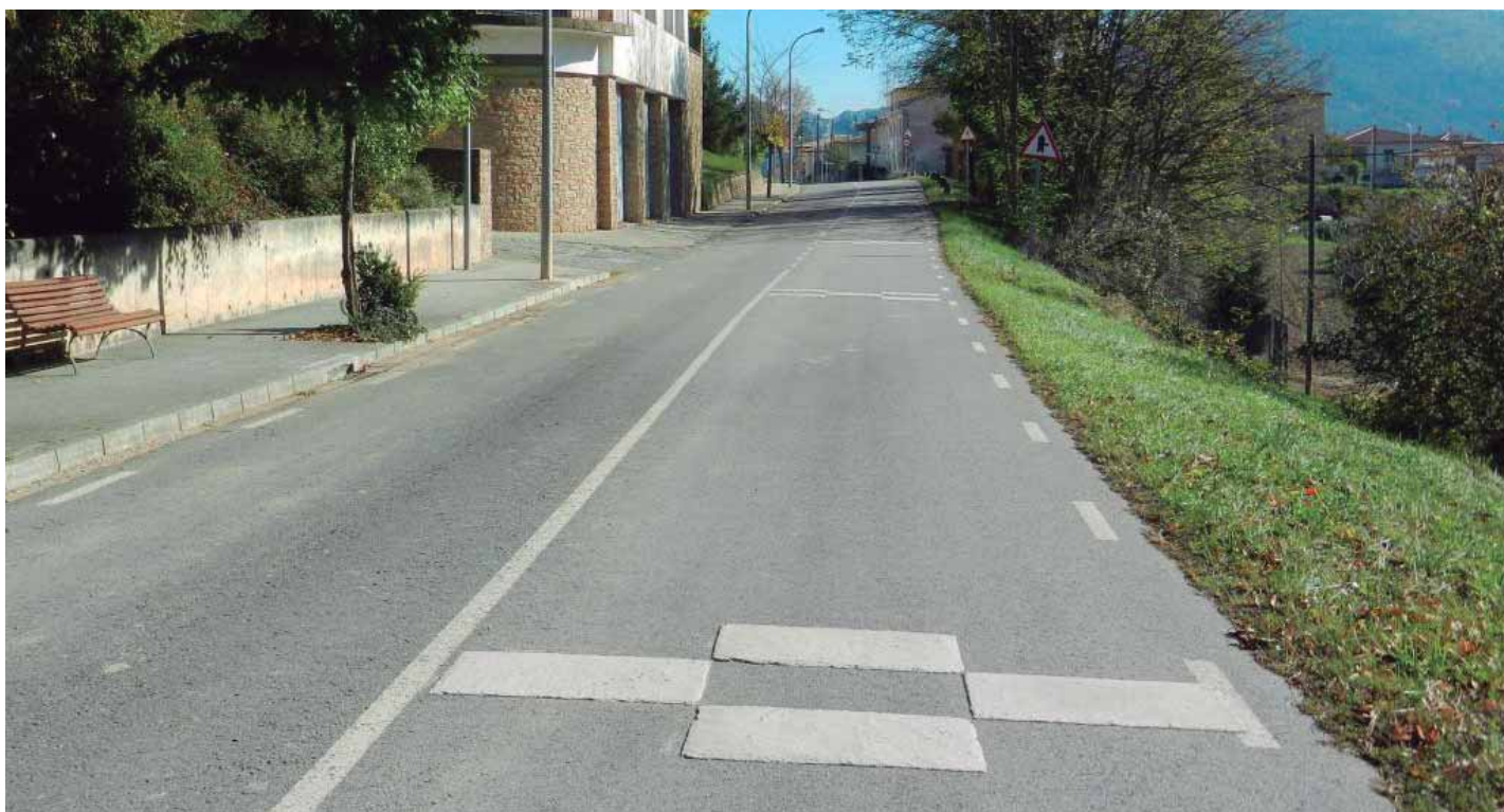
Elementos transversales de alerta.
