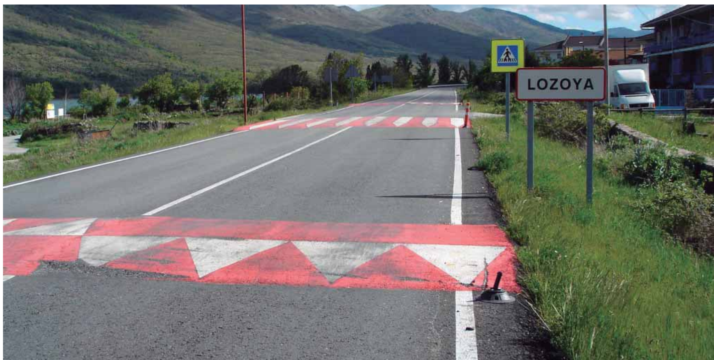
Combinación de lomo y paso peatonal sobre lomo en el primer tramo de una travesía.
