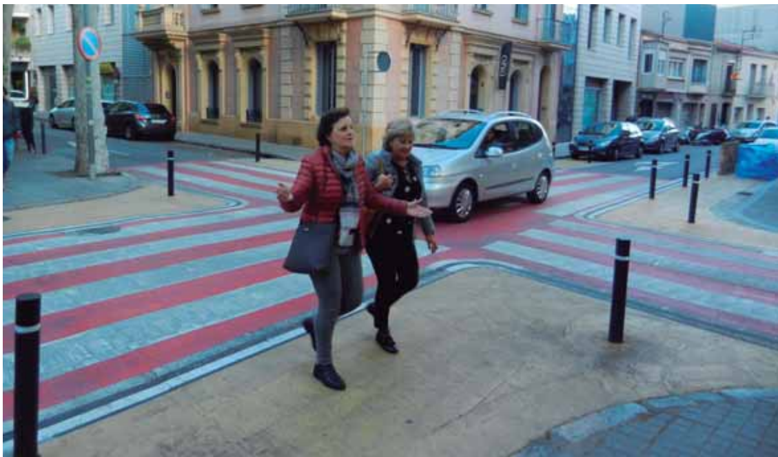
Tratamiento de intersección con pintura y bolardos para el calmado del tráfico y mejora del cruce peatonal en Sabadell.
