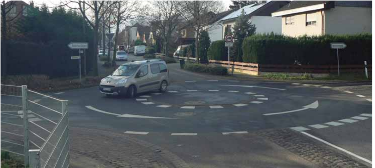
Microglorieta de acceso a un núcleo urbano en Alemania.
