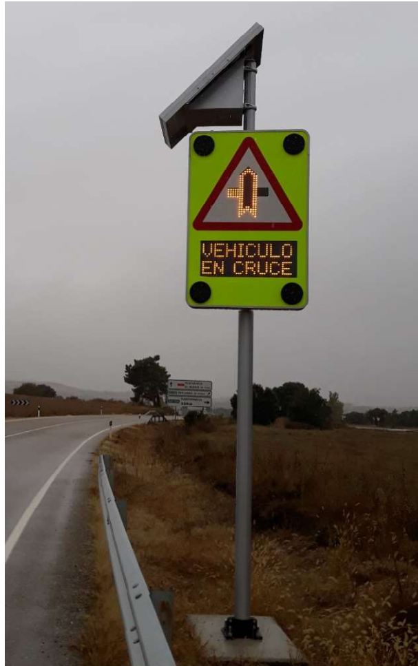
Señal de advertencia dinámica en carretera CL-116 pk 20+950
