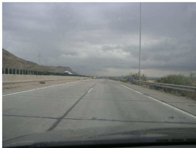
FIGURA 2.3.5. PÉRDIDA DE CONTRASTE CUANDO EL PAVIMENTO TIENE COLOR CLARO
