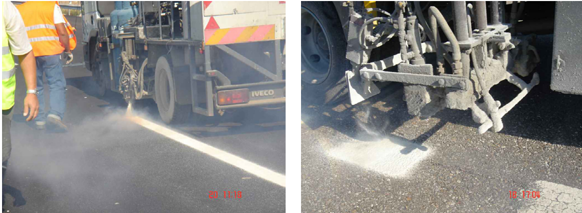
FIGURA 6.2.1. MÁQUINAS APLICANDO TERMOPLÁSTICO EN CALIENTE POR PULVERIZACIÓN
