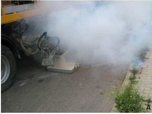
FIGURA 5.2.1. PROCESO DE AJUSTE EN OBRA. A) TOMA DE MUESTRA DEL MATERIAL SUMINISTRADO POR LA MÁQUINA EN LAS CONDICIONES DE TRABAJO PREVIAMENTE ESTABLECIDAS. B) PESADA DE LA MUESTRA TOMADA.
