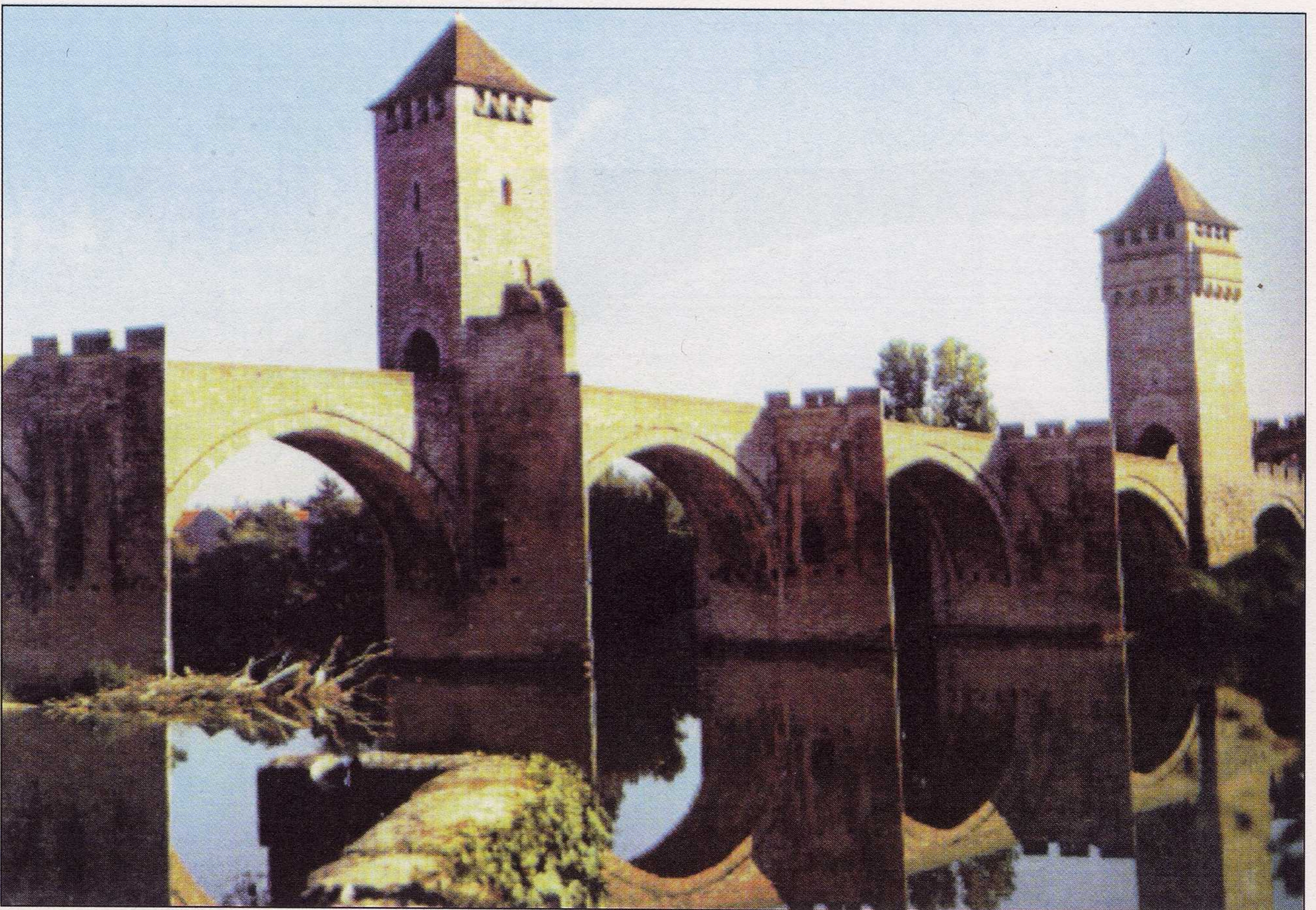
Figura 2.2 Puente medieval en Alemania
