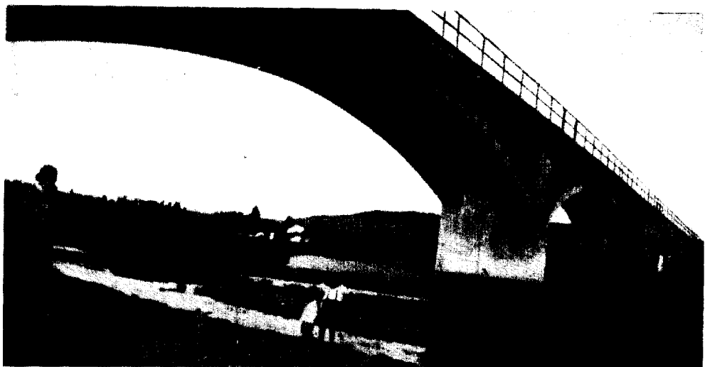
Figura 2.4 Puente sobre el Guadarrama (Eugenio Ribera)
