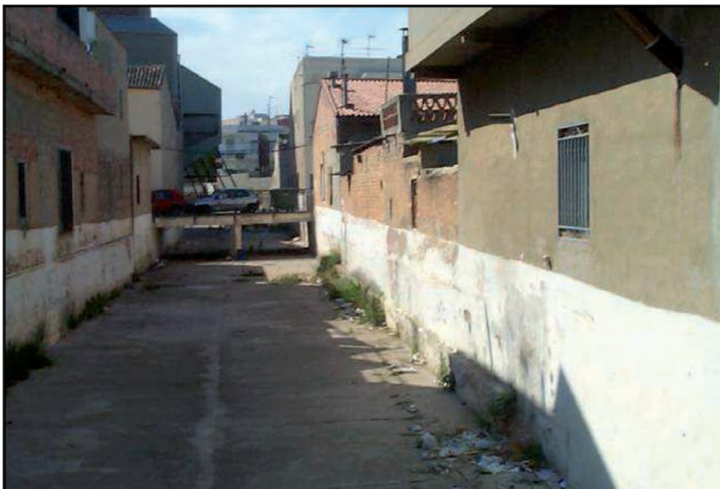
FIGURA 2.23.7. CAUCE DE TIPO «5: CAUCE REVESTIDO O ENCAUZADO».
