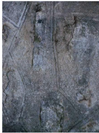
Fot5 Erosión/meteorización generalizada Lib.1
