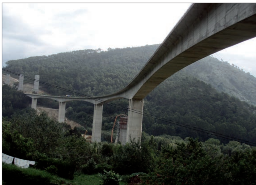
FIGURA 20. VIADUCTO DE CONCHA DE ARTEDO EN LA CARRETERA N-632.
