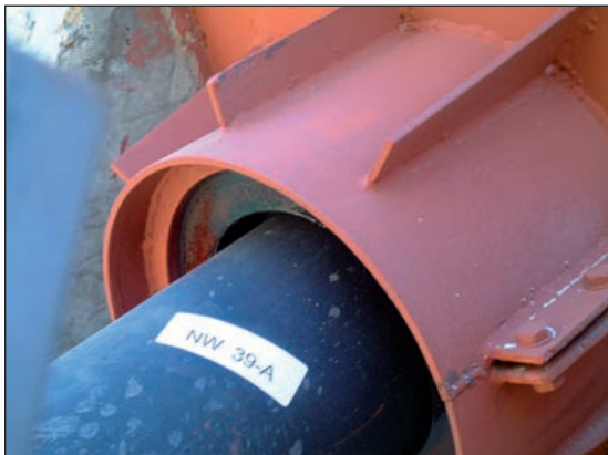
FIGURAS 220 Y 221. HOLGURAS ENTRE LOS TIRANTES Y EL ANILLO CENTRADOR DE NEOPRENO.
