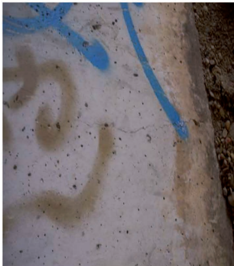
Fot1 Desconchón/Lajas sin armadura implicada lib1
