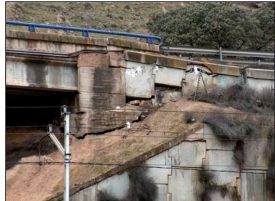
FIGURAS 264 Y 265. HUNDIMIENTO EN EL PAVIMENTO POR ASENTAMIENTOS DE LAS CAPAS SUBYACENTES (IZQUIERDA) Y ASENTAMIENTOS EN LOS EXTREMOS DEL PUENTE POR AUSENCIA O INEFICACIA DE LA LOSA DE TRANSICIÓN (DERECHA).
