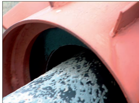
FIGURAS 220 Y 221. HOLGURAS ENTRE LOS TIRANTES Y EL ANILLO CENTRADOR DE NEOPRENO.
