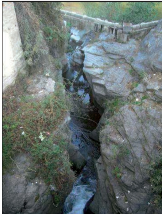
FIGURA 2.12.5. MATERIAL DE LA MARGEN DE TIPO «5: ROCA».
