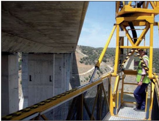
FIGURAS 30 Y 31. MEDIOS DE ACCESO EN UNA INSPECCIÓN PRINCIPAL DETALLADA (VÁLIDOS TAMBIÉN EN EL CASO DE UNA INSPECCIÓN ESPECIAL).
