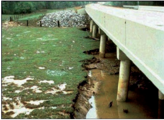
FIGURAS 2.7.1 Y 2.7.2. EJEMPLO DE FOSAS DE SOCAVACIÓN TOCANDO SUBESTRUCTURA Y FOSAS DE SOCAVACIÓN APRECIABLES PRÓXIMAS AL PUNTE.
