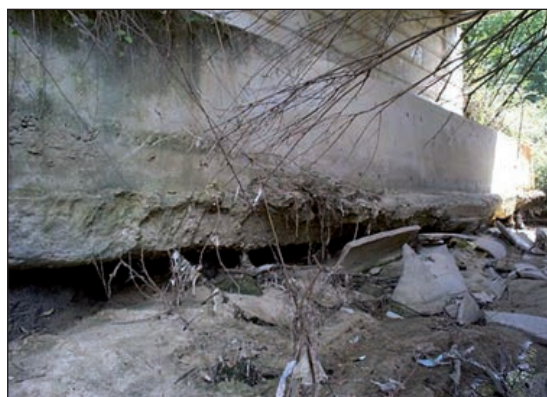
FIGURAS 96 Y 97. SOCAVACIÓN EN CIMENTACIONES SUPERFICIALES.
