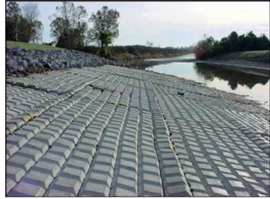
FIGURAS 2.13.7 Y 2.13.8. PROTECCIÓN DE LA MARGEN DE TIPO «8: ESCOLLERAS ANCLADAS» Y DE TIPO «5: ELEMENTOS PREFABRICADOS».
