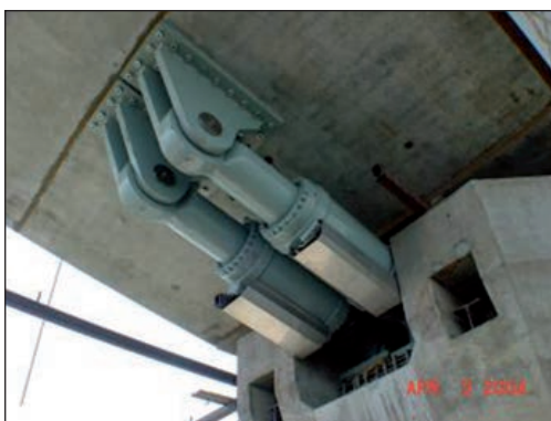
FIGURAS 88 Y 89. DISPOSITIVOS DISIPADORES DE ENERGÍA (Fuente: Conservación de aparatos de apoyo, juntas y drenaje en puentes; ACHE-ATC; 2011).
