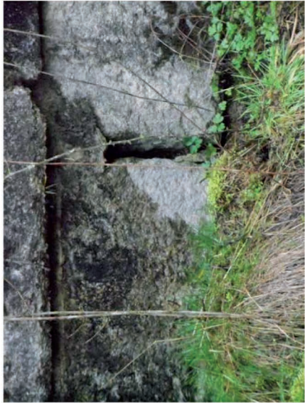
Fot2 Juntas degradadas/lavado de lagas Lib1
