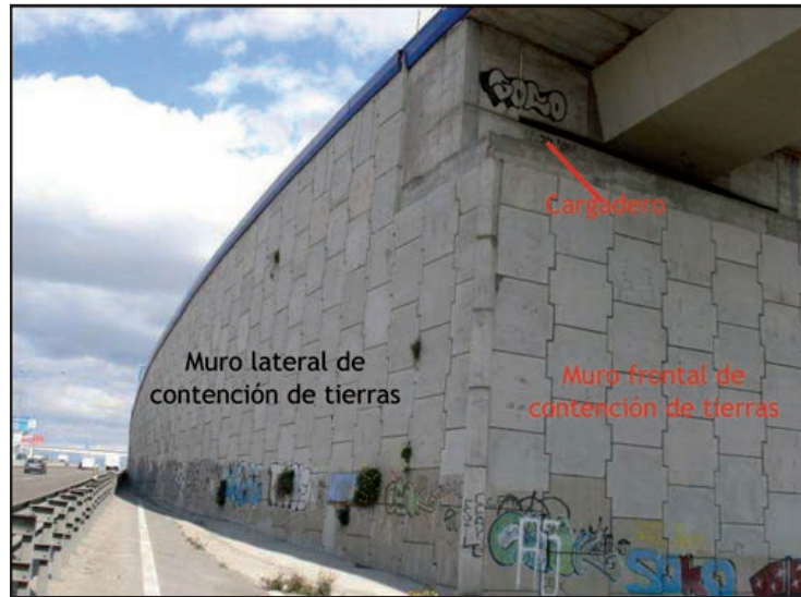
FIGURA 3.1.2. ELEMENTOS DE UN ESTRIBO FLOTANTE.
