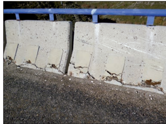
FIGURAS 278, 279, 280, 281. DEGRADACIÓN DEL HORMIGÓN DE UN PRETEL RÍGIDO (FOTO SUPERIOR IZQUIERDA) Y CORROSIÓN DE LA ARMADURA (RESTO DE IMÁGENES) EN ZONA DE INTENSA VIALIDAD INVERNAL.
