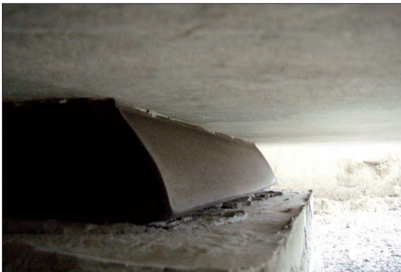
FIGURA 229. DESPEGUE DE APARATO DE APOYO.
