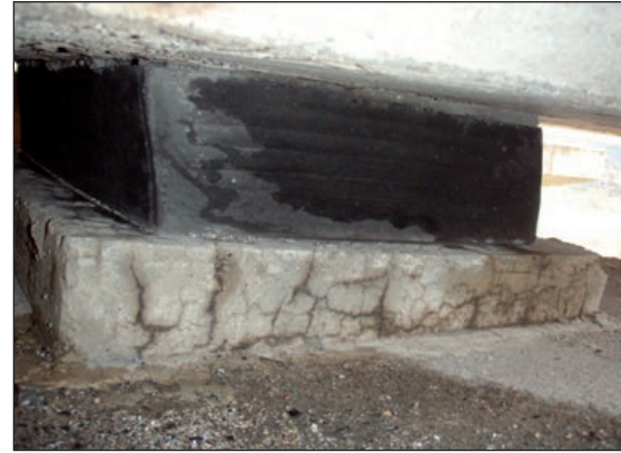
FIGURAS 238 Y 239. EJEMPLOS DE DEFECTOS EN LA CAMA DE NIVELACIÓN.
