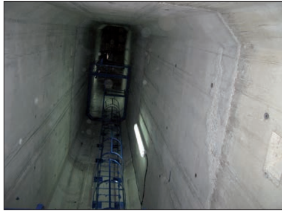
FIGURAS 40 Y 41. ESCALERAS DE PATES EN EL INTERIOR DE UNA PILA HUECA VISITABLE.
