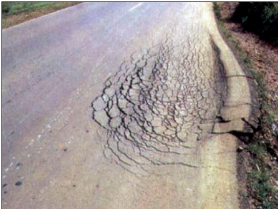
FIGURAS 264 Y 265. HUNDIMIENTO EN EL PAVIMENTO POR ASENTAMIENTOS DE LAS CAPAS SUBYACENTES (IZQUIERDA) Y ASENTAMIENTOS EN LOS EXTREMOS DEL PUENTE POR AUSENCIA O INEFICACIA DE LA LOSA DE TRANSICIÓN (DERECHA).
