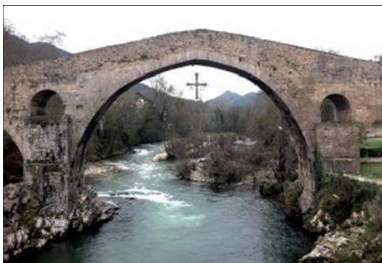
FIGURA 79. PUENTE DE PIEDRA EN CANGAS DE ONÍS (SIGLO XIII).
