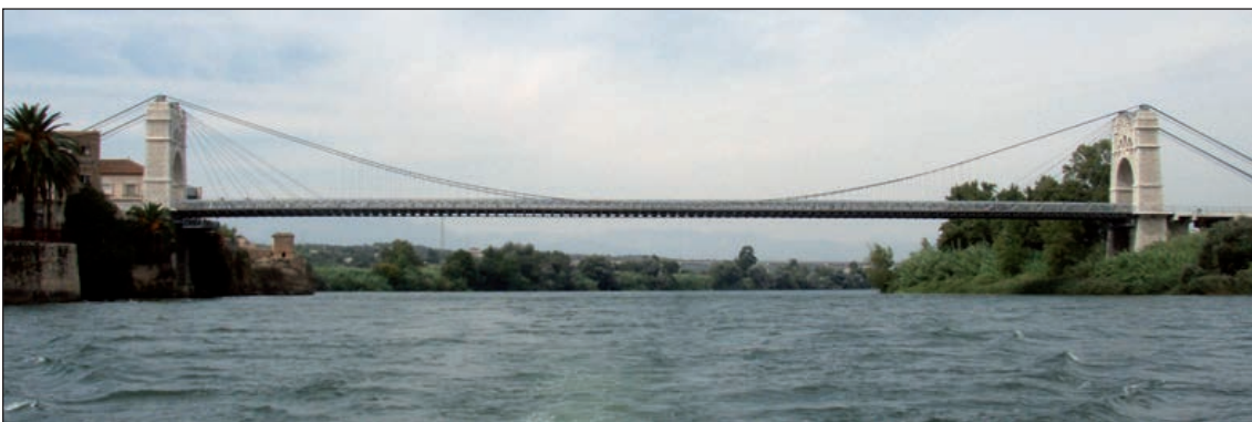
FIGURA 201. PUENTE SOBRE EL RÍO EBRO, EN AMPOSTA (TARRAGONA).
