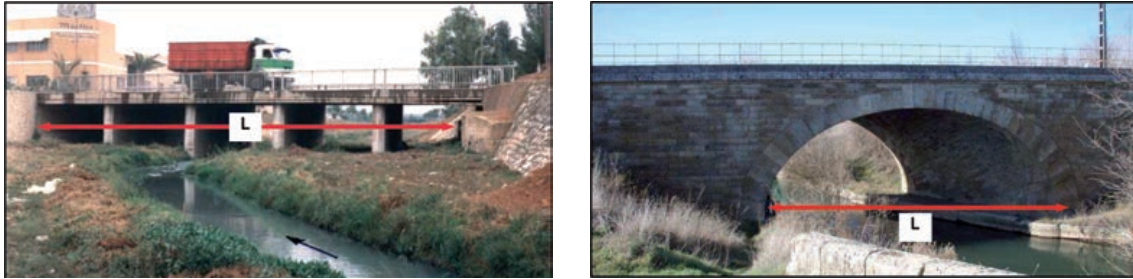
FIGURAS 2.2.1 Y 2.2.2. LONGITUD DEL PUENTE (ENTRE ESTRIBOS).
