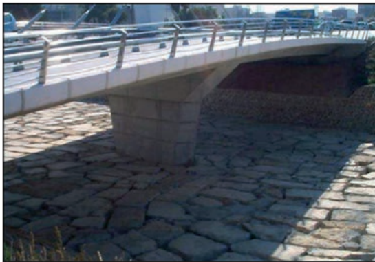
FIGURAS 4.5.3 Y 4.5.4. LECHO JUNTO A PILA CLASIFICADO COMO «TERRENO PROTEGIDO» Y CLASIFICADO COMO «EN ROCA».
