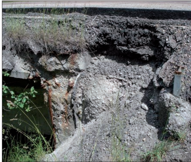
FIGURAS 290 Y 291. DEGRADACIÓN DEL HORMIGÓN EN UNA PILA Y EN UN ESTRIBO POR EFECTO DE HIELO-DESHIELO: ZONAS CON INTENSA VIALIDAD INVERNAL.
