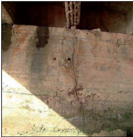
FIGURAS 4.7.2 Y 4.7.3. PILA «CON DAÑOS MEDIOS» Y CON «DAÑOS LEVES O SIN DAÑOS».
