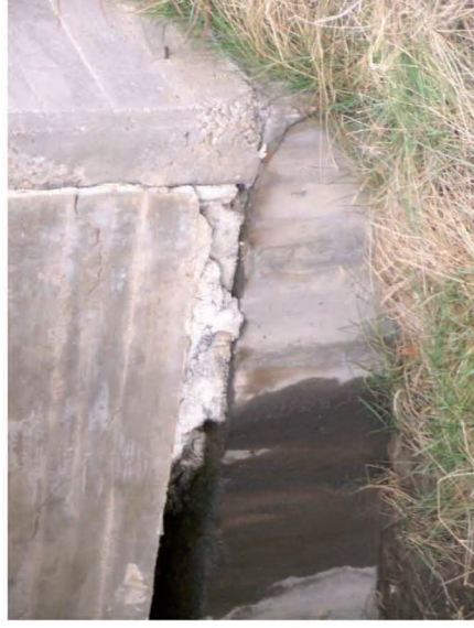
Fot3 Degradación superficial en dintel cargadero Lib.2
