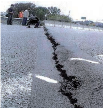
FIGURAS 243 Y 244. ROTURA DE LOS ANCLAJES DE APOYO EN ESTRIBO.
