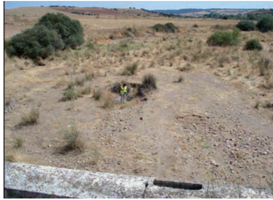
FIGURAS 2.7.1 Y 2.7.2. EJEMPLO DE FOSAS DE SOCAVACIÓN TOCANDO SUBESTRUCTURA Y FOSAS DE SOCAVACIÓN APRECIABLES PRÓXIMAS AL PUNTE.
