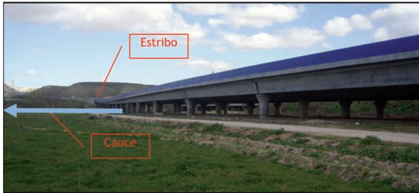
FIGURA 3.1.4. ESTRIBO EN «LLANURA DERECHA».
