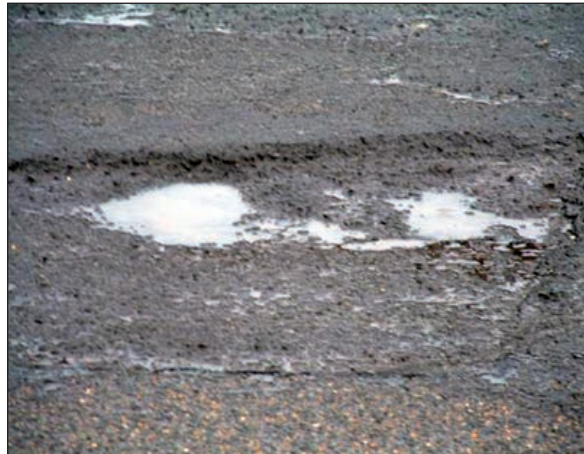
FIGURAS 260 Y 261. RODERAS EN PAVIMENTO ASFÁLTICO.
