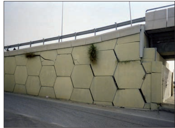
FIGURAS 110 Y 111. MOVIMIENTOS DE LAS PIEZAS DE TIERRA REFORZADA O ARMADA.
