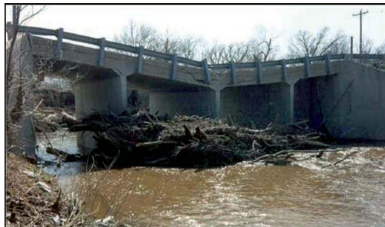
FIGURA 4.14.3. ANCHO DE ACARREO/FUSTE \approx 10 .
