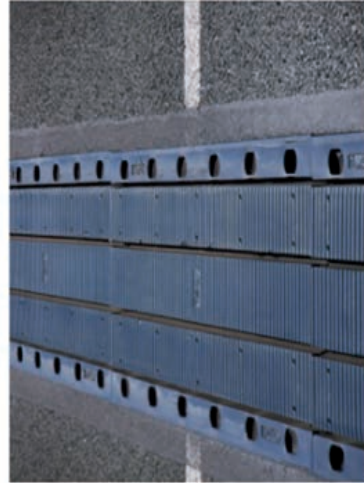
Det.2. Perd. Alineación entre placas.
