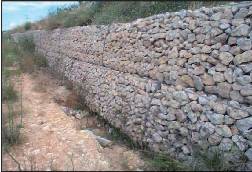
FIGURA 2.14.6. PROTECCIÓN DE LA MARGEN EN BUENAS CONDICIONES (SIN DAÑOS).
