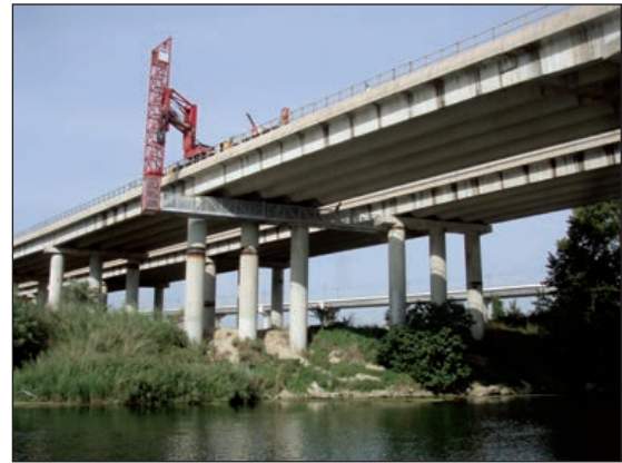
FIGURAS 30 Y 31. MEDIOS DE ACCESO EN UNA INSPECCIÓN PRINCIPAL DETALLADA (VÁLIDOS TAMBIÉN EN EL CASO DE UNA INSPECCIÓN ESPECIAL).
