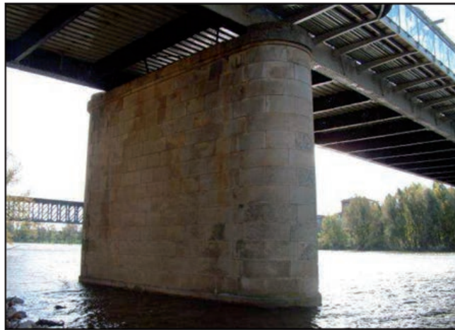
FIGURAS 4.7.2 Y 4.7.3. PILA «CON DAÑOS MEDIOS» Y CON «DAÑOS LEVES O SIN DAÑOS».
