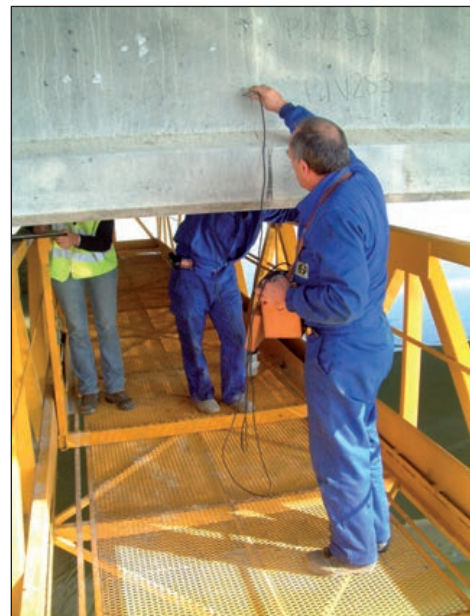
FIGURAS 46 Y 47. OPERACIONES DIVERSAS QUE PUEDEN ESTAR INCLUIDAS EN UNA INSPECCIÓN ESPECIAL
