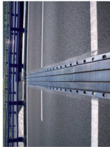
Det. 1. Perd. Elem. Protectores de anclajes.
