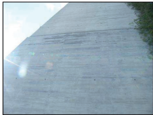
Fot.7. Humedades en murete de guarda (lib. 1)
