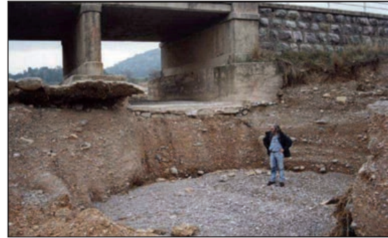
FIGURAS 4.10.2 Y 4.10.3. SOCAVACIÓN FUERTE EN PILA.
