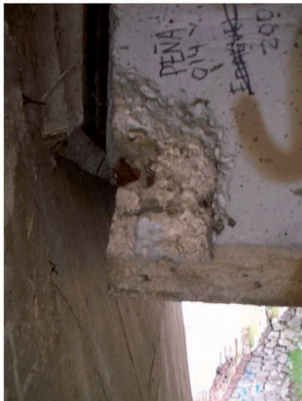
Fot1 Desconchón/Lajas sin armadura implicada lib1
