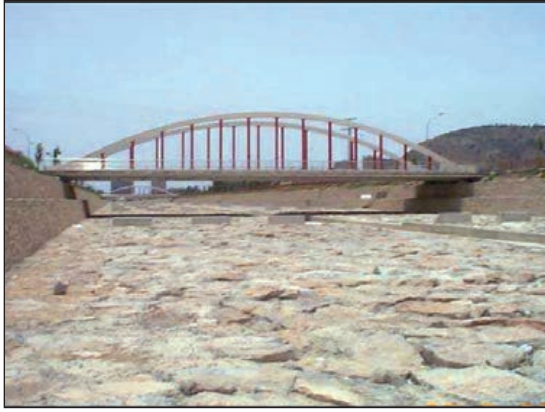
FIGURAS 2.13.7 Y 2.13.8. PROTECCIÓN DE LA MARGEN DE TIPO «8: ESCOLLERAS ANCLADAS» Y DE TIPO «5: ELEMENTOS PREFABRICADOS».
