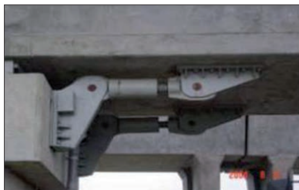
FIGURAS 88 Y 89. DISPOSITIVOS DISIPADORES DE ENERGÍA (Fuente: Conservación de aparatos de apoyo, juntas y drenaje en puentes; ACHE-ATC; 2011).
