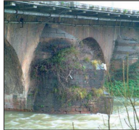
FIGURAS 4.16.3 Y 4.16.4. FORMA DEL FRENTE DE TIPO «CIRCULAR» Y DE TIPO «EN PUNTA».
