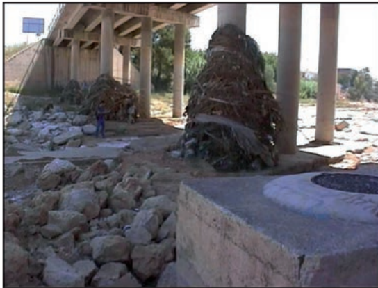
FIGURAS 4.14.1 Y 4.14.2. ANCHO DE ACARREO/FUSTE \approx 2,0 Y ANCHO DE ACARREO/FUSTE \approx 4 .
