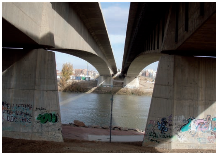
FIGURA 81. PUEBTE DE LA UNIÓN SOBRE EL RÍO EBRO, DE HORMIGÓN PRETENSADO (1980).
