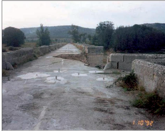
FIGURAS 179 Y 180. DESPRENDIMIENTO DEL TÍMPANO DE UNA OBRA DE FÁBRICA POR EMPUJE EXCESIVO DEL RELLENO DE TIERRAS.
