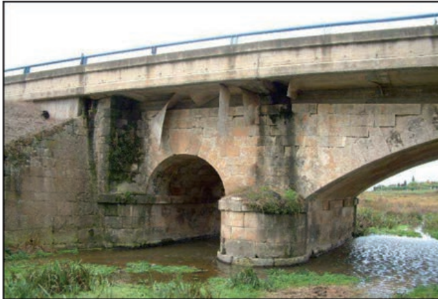
FIGURAS 4.16.3 Y 4.16.4. FORMA DEL FRENTE DE TIPO «CIRCULAR» Y DE TIPO «EN PUNTA».
