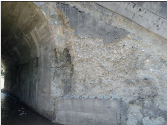
FIGURAS 292 Y 293. DEGRADACIÓN DEL HORMIGÓN EN UNA PILA Y EN UN ESTRIBO POR EFECTO DE HIELO-DESHIELO: ZONAS CON INTENSA VIALIDAD INVERNAL.
