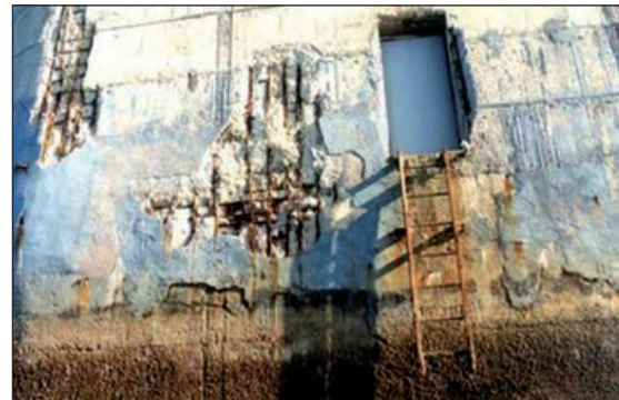
FIGURAS 318 Y 319. EFECTOS DE LA CORROSIÓN POR CLORUROS EN AMBIENTE MARINO.
