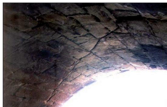
FIGURAS 184 Y 185 GRIETA EN BÓVEDA DE FÁBRICA DEBIDO A ASIENTOS DIFERENCIALES DE LA CIMENTACIÓN.
