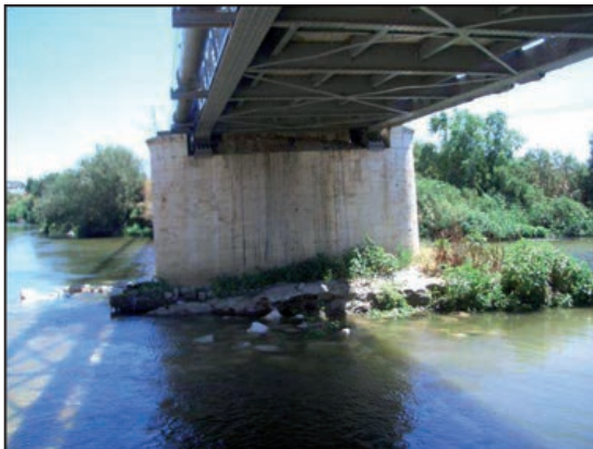
FIGURAS 4.17.1 Y 4.17.2. DESCENSO PARCIAL Y GIRO DE PILA.
