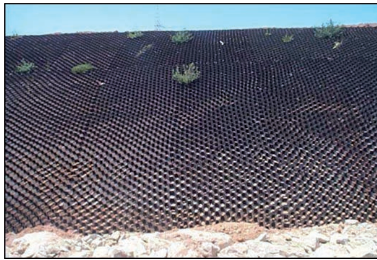
FIGURA 2.13.9. PROTECCIÓN DE LA MARGEN DE TIPO «4: GEOSINTÉTICOS».
