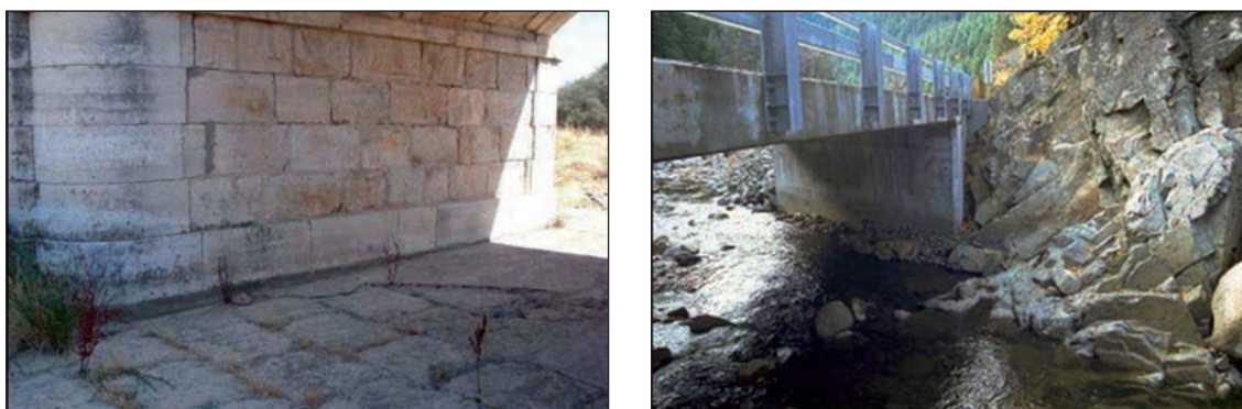
FIGURAS 3.5.3 Y 3.5.4. LECHO JUNTO AL ESTRIBO CLASIFICADO COMO «TERRENO PROTEGIDO» Y CLASIFICADO COMO «EN ROCA».
