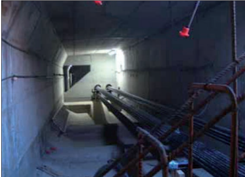
FIGURA 157. INSPECCIÓN DEL INTERIOR DE UN CAJÓN.
