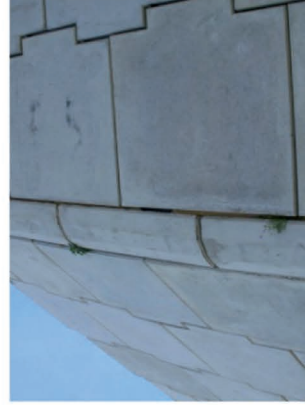
Det. 7. Deplazamiento rel. entre piezas.
