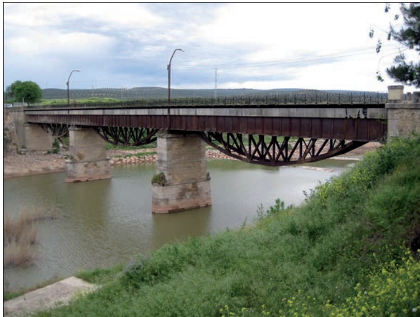
FIGURA 159. PUNTE METÁLICO SOBRE EL RÍO GUADALIMAR.
