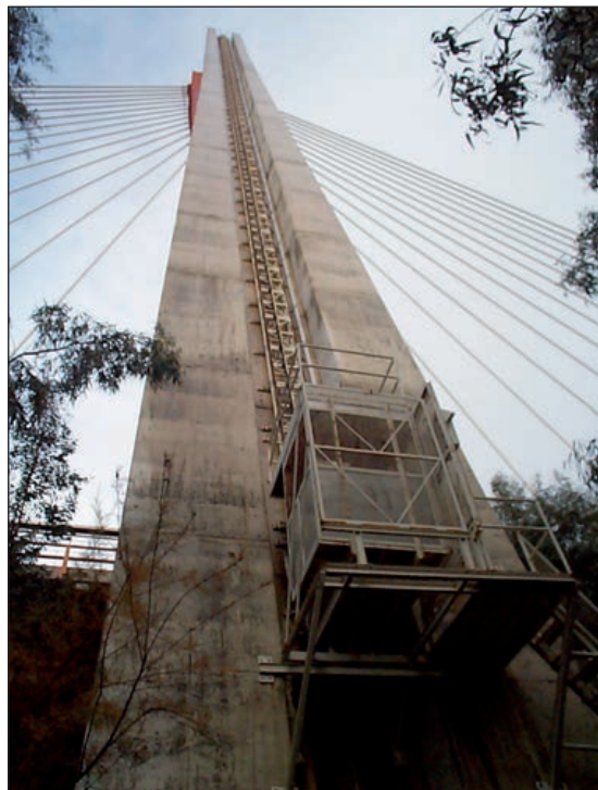
FIGURAS 44 Y 45. ASCENSOR EXTERIOR DE ACCESO A LA CORONACIÓN DE UN PILONO.
