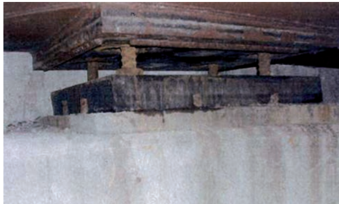
FIGURAS 243 Y 244. ROTURA DE LOS ANCLAJES DE APOYO EN ESTRIBO.
