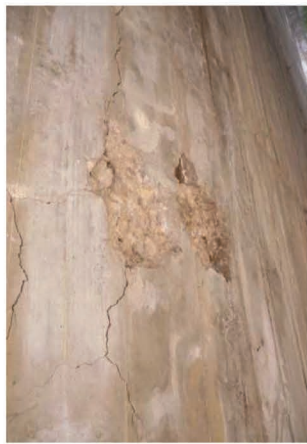
Fot1 Desconchón/Lajas sin armadura implicada Lib1
