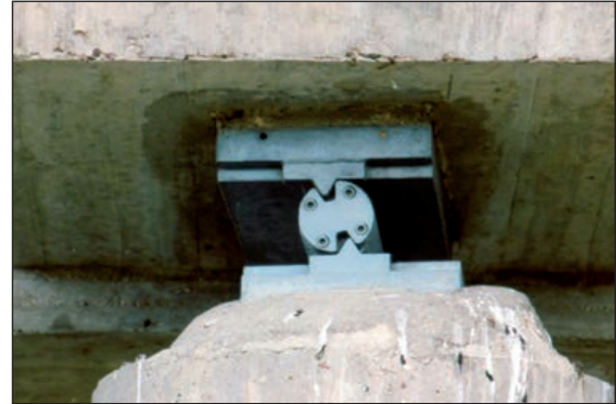
FIGURAS 233 Y 234. EJEMPLOS DE DISTORSIONES Y MOVIMIENTOS EXCESIVOS EN APARATOS DE APOYO.
