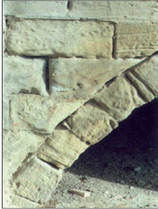
FIGURA 349. METEORIZACIÓN POR ACCIÓN DEL VIENTO.
