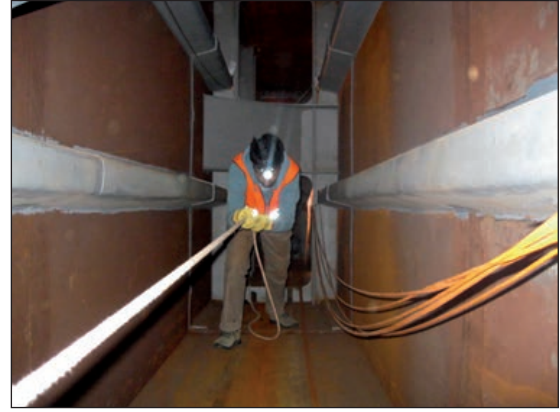
FIGURAS 34 Y 35. INSPECCIÓN DEL INTERIOR DEL CAJÓN DE UN PUEBTE MIXTO (IZQUIERDA) Y DE UN ARCO METÁLICO (DERECHA) EN EL MARCO DE UNA INSPECCIÓN PRINCIPAL DETALLADA.
