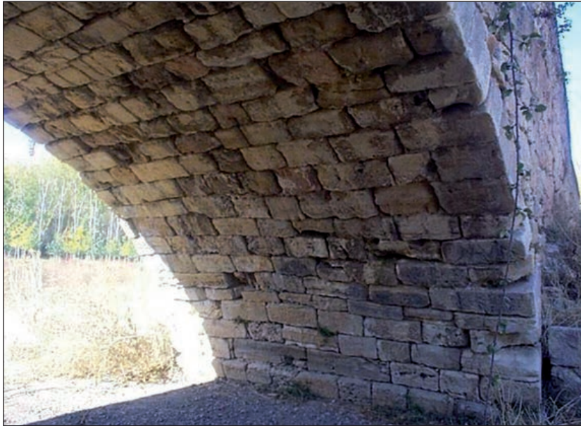
FIGURA 187. LAVADO DE LLAGAS EN BÓVEDA DE SILLERÍA.
