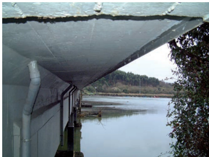
FIGURAS 267 Y 268. EN LA FOTO DE LA IZQUIERDA PUEDE COMPROBARSE EL EFECTO SOBRE LA ESTRUCTURA DE UN SISTEMA DE DRENAJE INADECUADO O INEXISTENTE. EN LA FOTO DE LA DERECHA SE PUEDE OBSERVAR LA DISPOSICIÓN DE UN SISTEMA DE DRENAJE ADECUADO.
