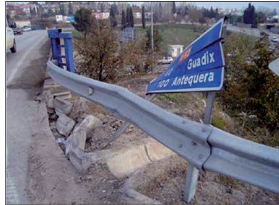
FIGURAS 272 Y 273. ROTURA DE PRETIL (IZQUIERDA) Y DEFORMACIÓN DE BARRERA EN UN ACCESO (DERECHA).
