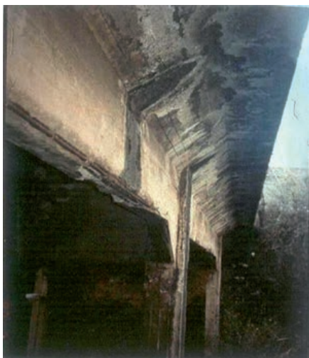
FIGURAS 267 Y 268. EN LA FOTO DE LA IZQUIERDA PUEDE COMPROBARSE EL EFECTO SOBRE LA ESTRUCTURA DE UN SISTEMA DE DRENAJE INADECUADO O INEXISTENTE. EN LA FOTO DE LA DERECHA SE PUEDE OBSERVAR LA DISPOSICIÓN DE UN SISTEMA DE DRENAJE ADECUADO.
