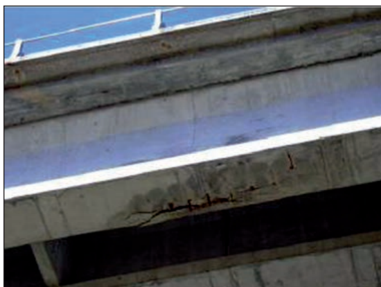
FIGURAS 135Y 136. DAÑOS POR CORROSIÓN EN VIGAS LATERALES DEL TABLERO.
