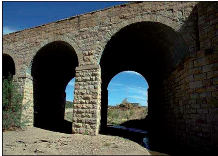
FIGURA 4.5.2. LECHO JUNTO A PILA CLASIFICADO COMO «SUELO COMPETENTE».
