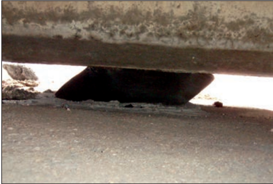
FIGURAS 233 Y 234. EJEMPLOS DE DISTORSIONES Y MOVIMIENTOS EXCESIVOS EN APARATOS DE APOYO.
