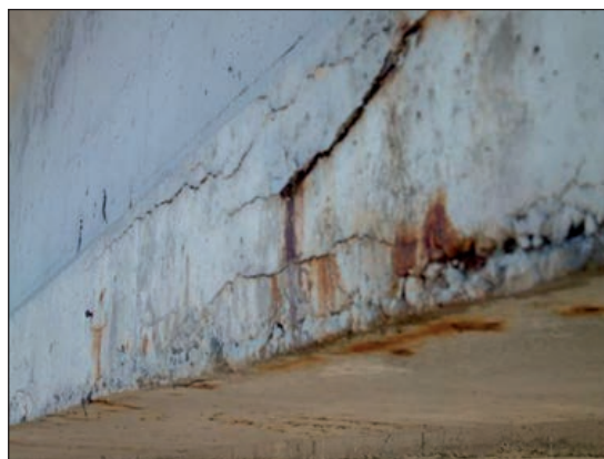
FIGURAS 135Y 136. DAÑOS POR CORROSIÓN EN VIGAS LATERALES DEL TABLERO.
