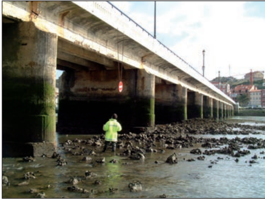
FIGURAS 61 Y 62. INSPECCIÓN PRINCIPAL CON CORRIENTES SOMERAS.
