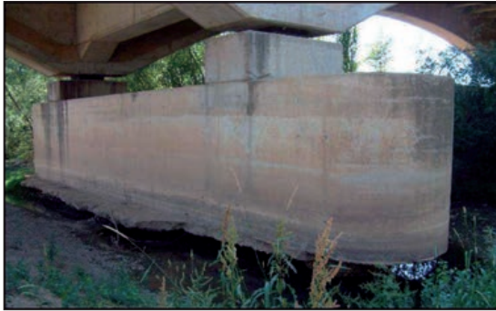
FIGURAS 4.10.2 Y 4.10.3. SOCAVACIÓN FUERTE EN PILA.
