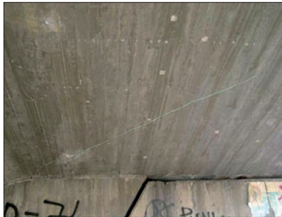
FIGURAS 338 Y 339. FISURACIÓN POR TORSIÓN EN UNA VIGA (IZQUIERDA) Y EN UNA LOSA (DERECHA).
