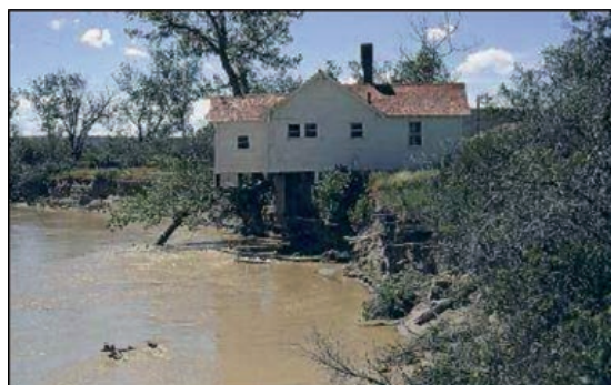
FIGURAS 2.8.1 Y 2.8.2. EROSIÓN DE LA MARGEN DE TIPO «1: EROSIÓN SEVERA».
