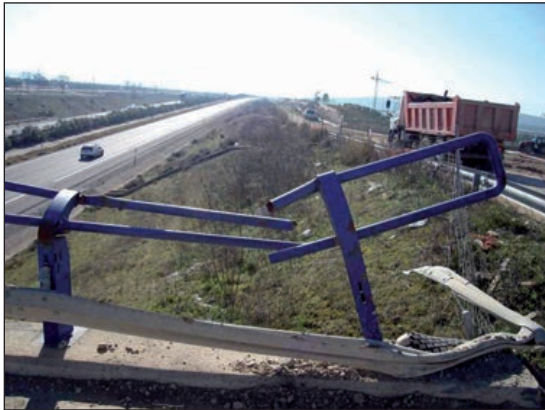
FIGURAS 272 Y 273. ROTURA DE PRETIL (IZQUIERDA) Y DEFORMACIÓN DE BARRERA EN UN ACCESO (DERECHA).
