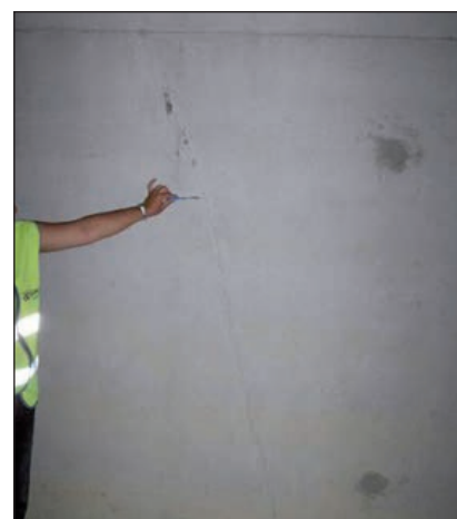
FIGURAS 190 Y 191. FISURAS INCLINADAS EN BÓVEDA DE HORMIGÓN POR ASIENTO DE LA CIMENTACIÓN.
