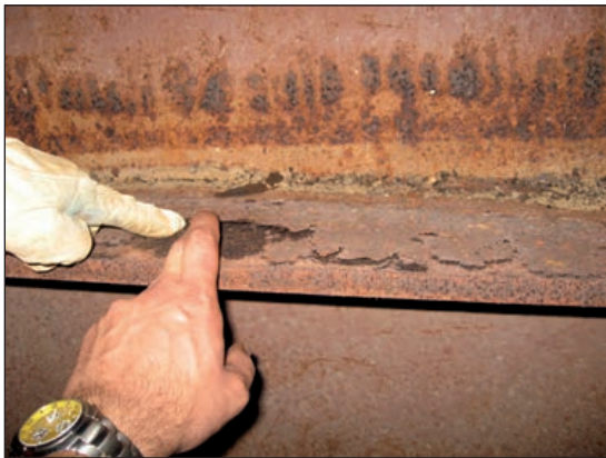
FIGURAS 168 Y 169. CORROSIÓN AVANZADA EN EL INTERIOR DE UN CAJÓN METÁLICO.
