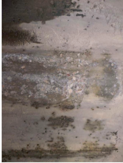
Fot2 Degradación superficial en dintel cargadero Lib.4
