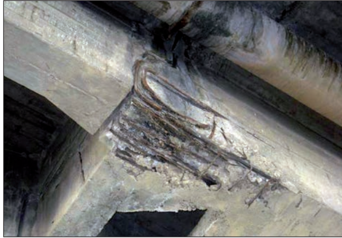
FIGURAS 241 Y 242. EJEMPLOS DE DEGRADACIÓN DE APOYOS A MEDIA MADERA.
