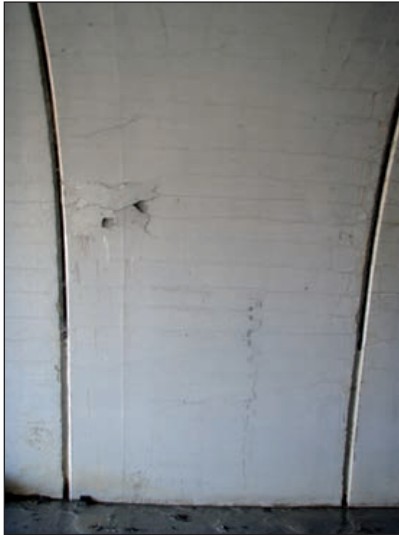
FIGURAS 195 Y 196. FISURAS HORIZONTALES Y LEY DE MOMENTOS EN LA BÓVEDA BAJO CARGAS ASIMÉTRICAS.
