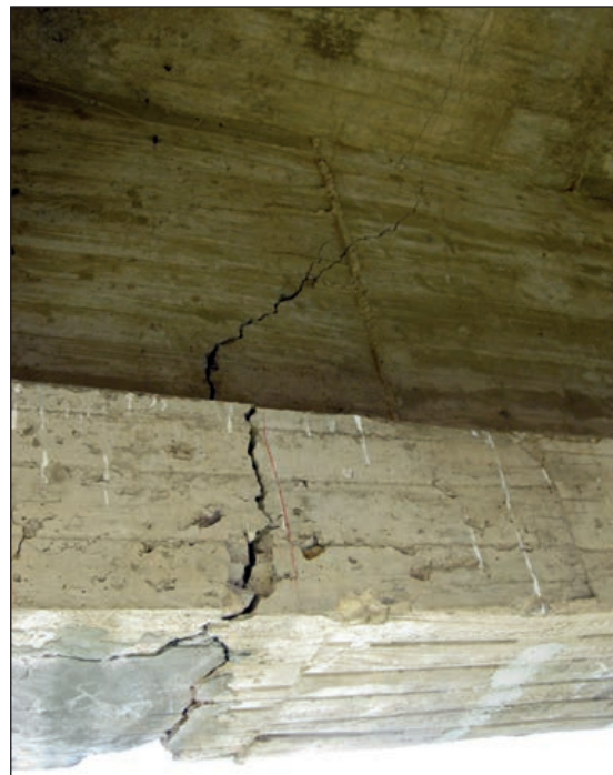
FIGURAS 340 Y 341. LA EXISTENCIA DE FISURAS EN TODOS LOS VANOS, QUE HAN APARECIDO DESDE EL MOMENTO DE LA PUESTA EN SERVICIO Y QUE HAN IDO EVOLUCIONANDO CON EL TIEMPO, HACE PRESUPONER UN FALLO EN EL CÁLCULO ESTRUCTURAL O DE EJECUCIÓN.
