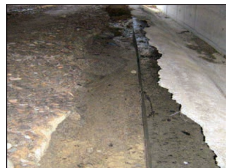
FIGURAS 3.10.3 Y 3.10.4. SOCACCIÓN AVANZADA EN ESTRIBO.
