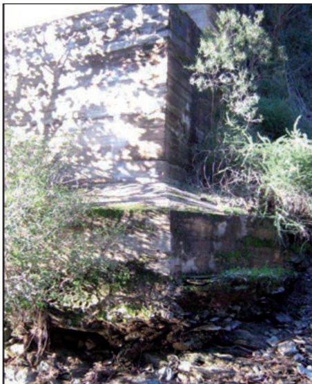
FIGURA 3.10.2. SOCACCIÓN FUERTE EN ESTRIBO.
