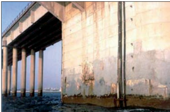
FIGURAS 318 Y 319. EFECTOS DE LA CORROSIÓN POR CLORUROS EN AMBIENTE MARINO.
