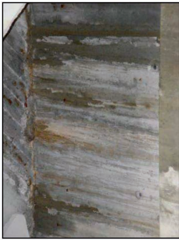
Fot.7. Humedades en murete de guarda (lib. 1)
