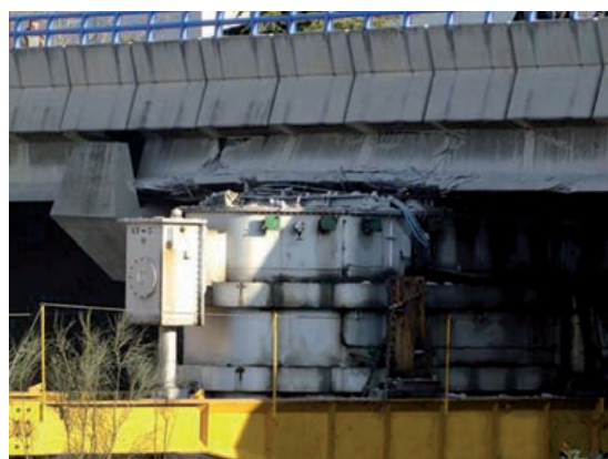
FIGURAS 285 Y 286. GOLPE EN CAJÓN METÁLICO (IZQUIERDA), Y GOLPE EN VIGA DE PASO SUPERIOR (DERECHA).
