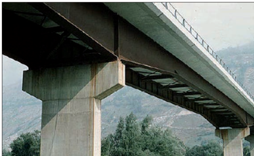
FIGURA 160. VISTA GENERAL DE UN PUENTE MIXTO BIJÁCENA SIN HORMIGÓN DE FONDO.
