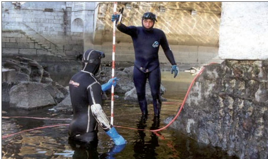
FIGURA 65. REALIZACIÓN DE BATIMETRÍA DEL FONDO DURANTE UNA INSPECCIÓN SUBACUÁTICA.
