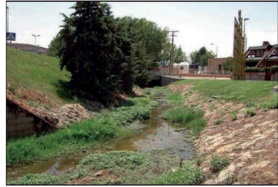
FIGURAS 2.8.3 Y 2.8.4. EROSIÓN DE LA MARGEN DE TIPO «2: EROSIÓN SUAVE» Y DE TIPO «3: SIN EROSIÓN».
