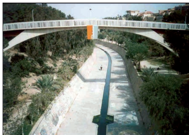
FIGURA 2.13.1. PROTECCIÓN MIXTA DE LA MARGEN DE TIPO «3: BIOINGENIERÍA» Y DE TIPO «9: HORMIGÓN».
