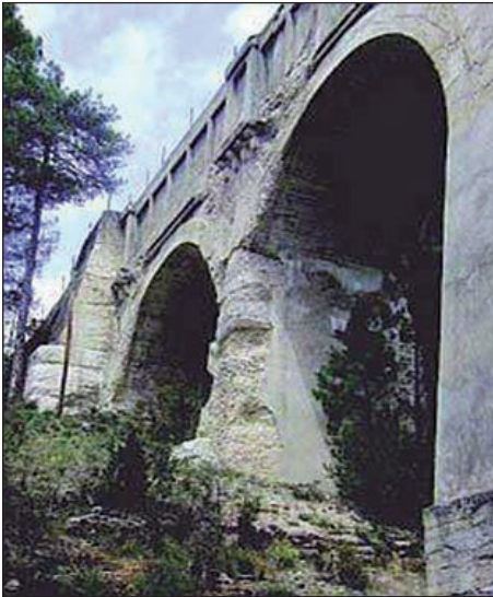
FIGURAS 290 Y 291. DEGRADACIÓN DEL HORMIGÓN EN UNA PILA Y EN UN ESTRIBO POR EFECTO DE HIELO-DESHIELO: ZONAS CON INTENSA VIALIDAD INVERNAL.
