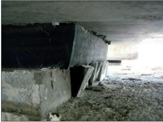
FIGURAS 238 Y 239. EJEMPLOS DE DEFECTOS EN LA CAMA DE NIVELACIÓN.
