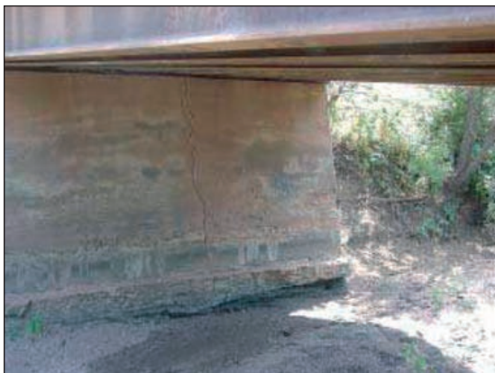
FIGURAS 3.7.2 Y 3.7.3. ESTRIBO «CON DAÑOS MEDIOS» Y CON «DAÑOS LEVES O SIN DAÑOS».
