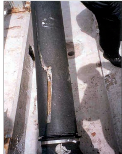
FIGURAS 204 Y 205. FISURACIÓN DE LA VAINA DE POLIETILENO DEL RECUBRIMIENTO. SE PUEDE OBSERVAR EL MORTERO DEL INTERIOR Y MANCHAS DE ÓXIDO, QUE PODRÍAN SER INDICATIVAS DE CORROSIÓN EN LOS ALAMBRES.
