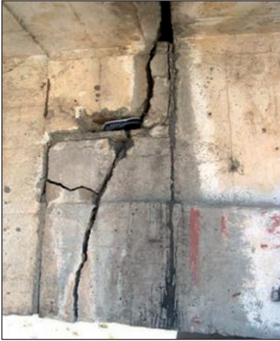
FIGURAS 241 Y 242. EJEMPLOS DE DEGRADACIÓN DE APOYOS A MEDIA MADERA.
