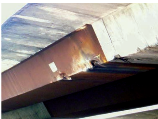
FIGURAS 285 Y 286. GOLPE EN CAJÓN METÁLICO (IZQUIERDA), Y GOLPE EN VIGA DE PASO SUPERIOR (DERECHA).
