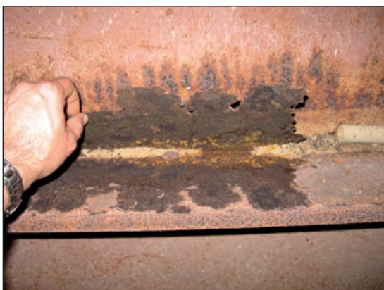
FIGURAS 170 Y 171. DETALLE DE CORROSIÓN EN EL INTERIOR DE UN CAJÓN METÁLICO.
