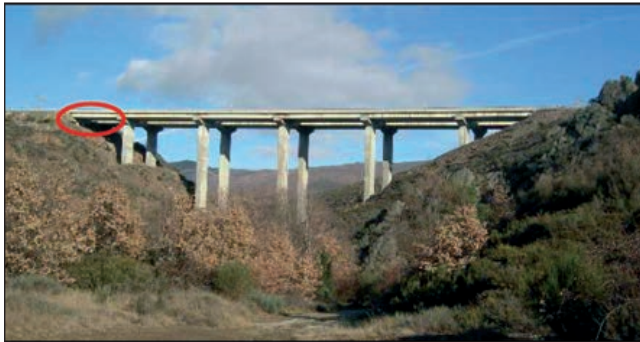
FIGURAS 3.1.5 Y 3.1.6. ESTRIBO EN «MARGEN DERECHA» Y EN «CAUCE».
