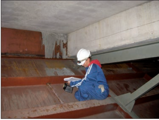
FIGURAS 34 Y 35. INSPECCIÓN DEL INTERIOR DEL CAJÓN DE UN PUEBTE MIXTO (IZQUIERDA) Y DE UN ARCO METÁLICO (DERECHA) EN EL MARCO DE UNA INSPECCIÓN PRINCIPAL DETALLADA.
