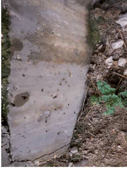
Fot3 Degradación superficial en dintel cargadero Lib.2
