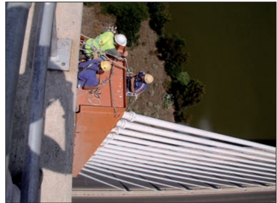
FIGURAS 38 Y 39. INSPECCIÓN CON EQUIPOS DE TRABAJO EN ALTURA EN EL MARCO DE UNA INSPECCIÓN PRINCIPAL DETALLADA.
