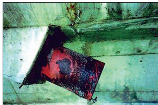
FIGURAS 215 Y 216. CAPOTS DE ANCLAJE CON PROBLEMAS DE CORROSIÓN.
