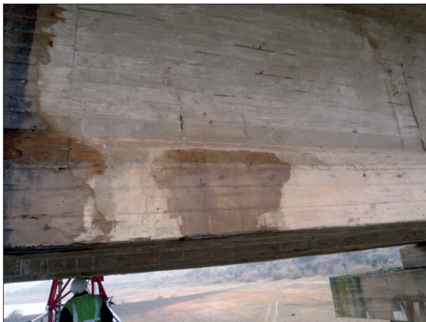
FIGURA 142. FISURAS EN CABEZA O PATÍN INFERIOR DE VIGA DOBLE T.
