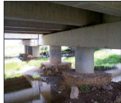
FIGURAS 4.10.4 Y 4.10.5. SOCAVACIÓN AVANZADA EN PILA.
