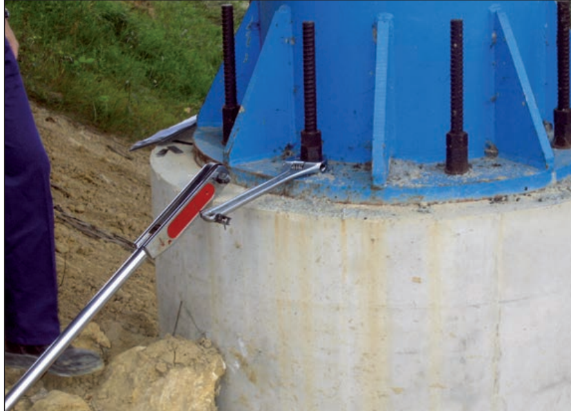
FIGURA 367. UNIÓN ATORNILLADA.
