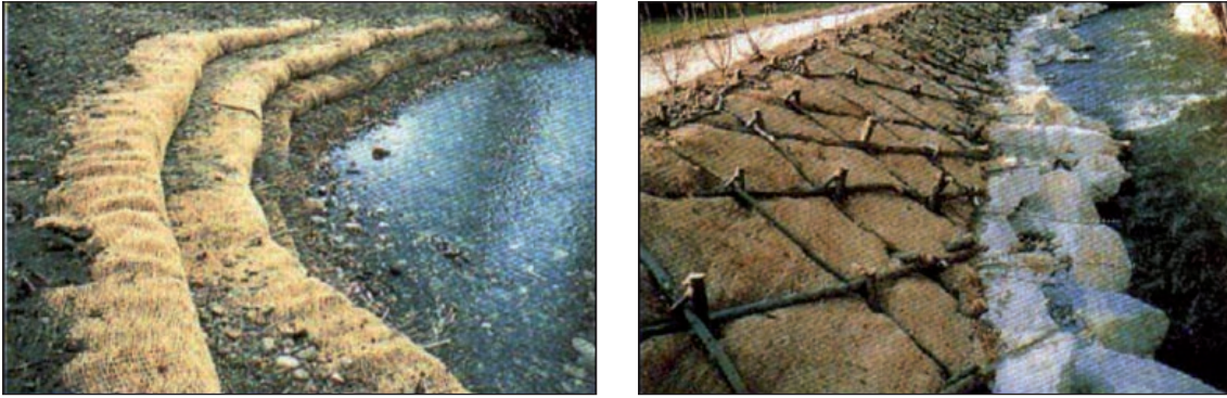
FIGURA 2.13.2. PROTECCIÓN DE LA MARGEN DE TIPO «3: BIOINGENIERÍA» (MARGEN REVESTIDA CON TÉCNICAS DE BIOINGENIERÍA: FIBRAS NATURALES (ESPARTO, COCO), CON REFUERZO DE ESQUEJES VIVOS DE SAUCE Y CHOPO).
