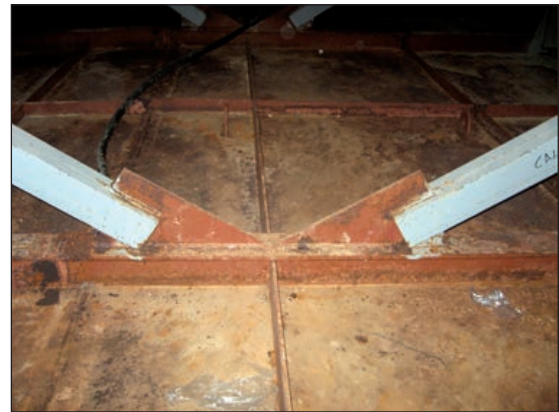
FIGURAS 168 Y 169. CORROSIÓN AVANZADA EN EL INTERIOR DE UN CAJÓN METÁLICO.
