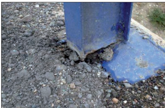
FIGURAS 276 Y 277. FALLOS EN LAS CONEXIONES DEL SISTEMA DE CONTENCIÓN.
