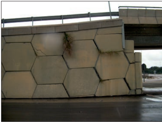
FIGURAS 110 Y 111. MOVIMIENTOS DE LAS PIEZAS DE TIERRA REFORZADA O ARMADA.
