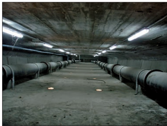
FIGURAS 42 Y 43. INTERIOR ILUMINADO DEL CAJÓN DEL TABLERO DE UN PUENTE ARCO.
