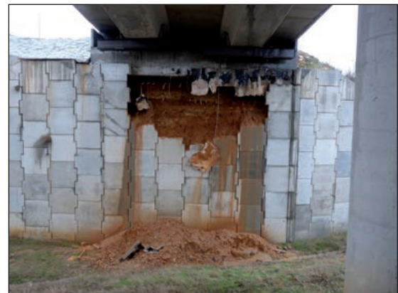
FIGURAS 112 Y 113. VEGETACIÓN EN MURO DE TIERRA REFORZADA O ARMADA (IZQUIERDA) Y ROTURA DE ESTRIBO DE TIERRA REFORZADA O ARMADA (DERECHA).
