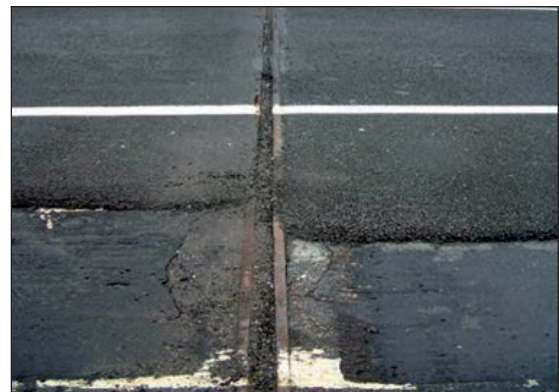
FIGURAS 247 Y 248. ATERRAMIENTO Y VEGETACIÓN QUE DIFICULTAN EL LIBRE MOVIMIENTO DE UNA JUNTA TIPO PEINE (IZQUIERDA) Y REPAVIMENTACIÓN QUE IMPIDE TOTALMENTE EL MOVIMIENTO (DERECHA).
