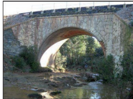
FIGURAS 3.1.5 Y 3.1.6. ESTRIBO EN «MARGEN DERECHA» Y EN «CAUCE».
