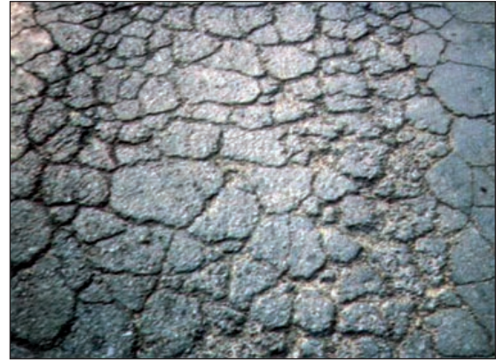
FIGURAS 257 Y 258. DISTINTAS ETAPAS EN EL PROCESO DE FORMACIÓN DE LAS GRIETAS DE «PIEL DE COCODRILO».
