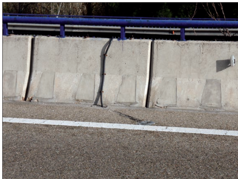
FIGURA 289. DIFUSORES PERMANENTES DE SALMUERA SOBRE TABLERO DE PUENTE.
