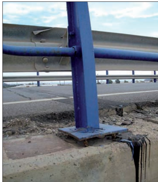
FIGURAS 276 Y 277. FALLOS EN LAS CONEXIONES DEL SISTEMA DE CONTENCIÓN.
