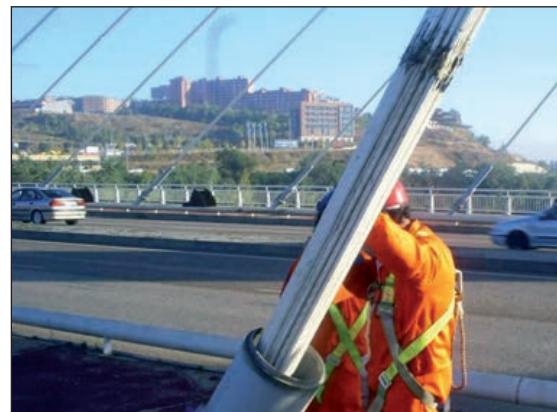
FIGURAS 224 Y 225. EXCESO DE DESVÍO EN HAZ DE TIRANTE.
