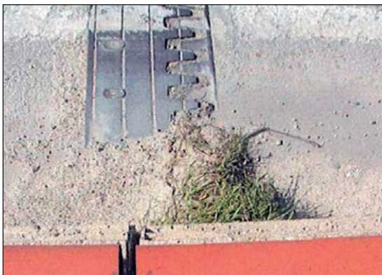
FIGURAS 247 Y 248. ATERRAMIENTO Y VEGETACIÓN QUE DIFICULTAN EL LIBRE MOVIMIENTO DE UNA JUNTA TIPO PEINE (IZQUIERDA) Y REPAVIMENTACIÓN QUE IMPIDE TOTALMENTE EL MOVIMIENTO (DERECHA).
