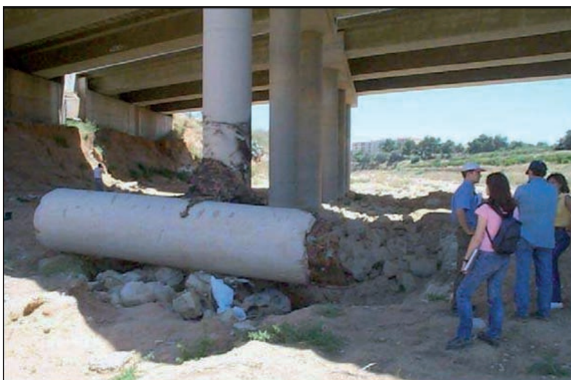
FIGURA 2.16.4. ACUMULACIÓN DENTRO DE UN CAUCE.
