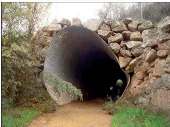
FIGURA 197 Y 198. DEFORMACIÓN EN TUBOS METÁLICOS.
