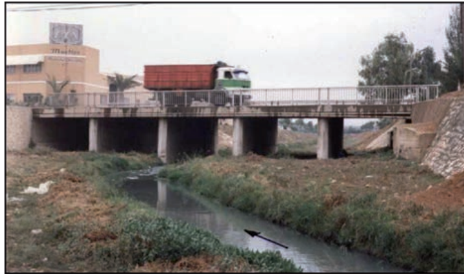
FIGURA 2.4.2. VISTA GENERAL DE CAUCE EN AGUAS BAJAS.
