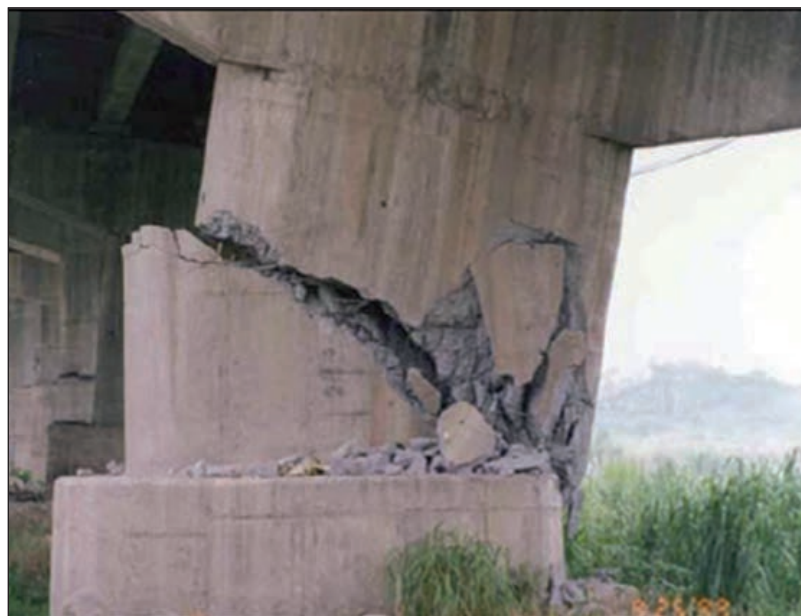
FIGURAS 129 Y 130. ESQUEMA DE FISURACIÓN POR CORTANTE EN UNA PILA. A LA DERECHA, ROTURA POR CORTANTE EN LA PILA TRAS UN SISMO (PUENTE U SHI - TAIWAN, 1999). ES MUY INFRECLENTE OBSERVAR FISURAS SIN QUE SE HAYA PRODUCIDO LA ROTURA.
