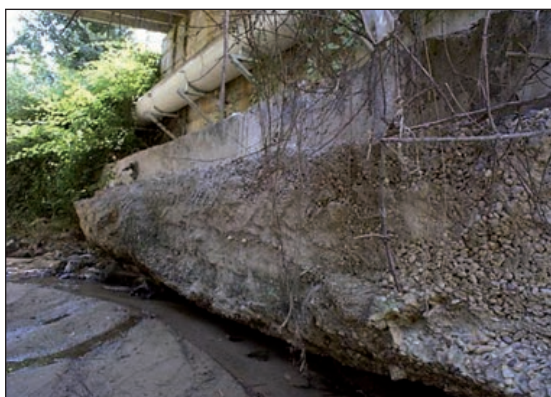
FIGURAS 96 Y 97. SOCAVACIÓN EN CIMENTACIONES SUPERFICIALES.
