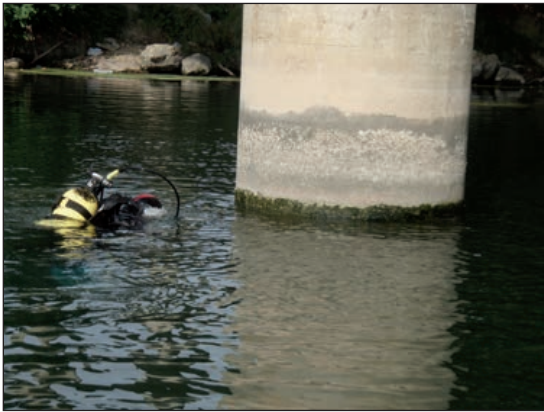
FIGURAS 36 Y 37. INSPECCIÓN SUBACUÁTICA EN UNA INSPECCIÓN PRINCIPAL DETALLADA.
