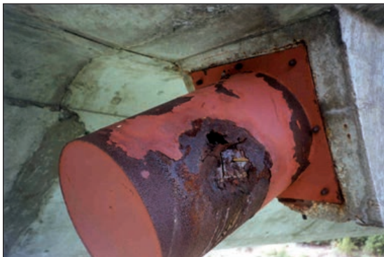
FIGURAS 215 Y 216. CAPOTS DE ANCLAJE CON PROBLEMAS DE CORROSIÓN.
