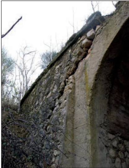
FIGURAS 179 Y 180. DESPRENDIMIENTO DEL TÍMPANO DE UNA OBRA DE FÁBRICA POR EMPUJE EXCESIVO DEL RELLENO DE TIERRAS.
