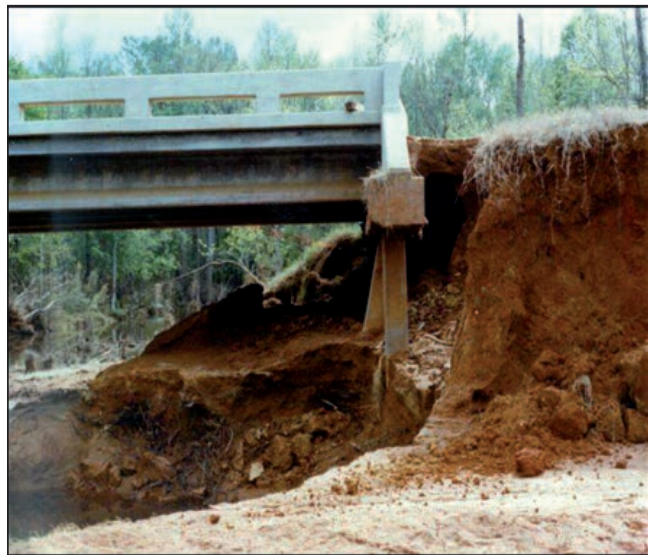
FIGURA 3.10.2. SOCACCIÓN FUERTE EN ESTRIBO.
