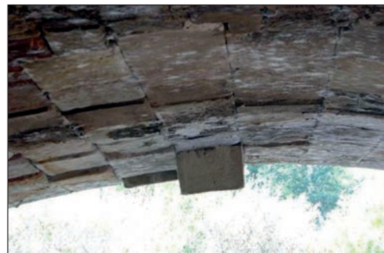
FIGURAS 181 Y 182. DESLIZAMIENTO DE DOVELAS EN BÓVEDA DE FÁBRICA.
