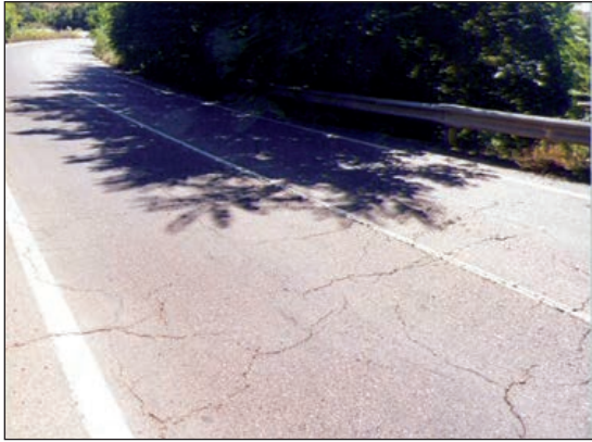
FIGURAS 257 Y 258. DISTINTAS ETAPAS EN EL PROCESO DE FORMACIÓN DE LAS GRIETAS DE «PIEL DE COCODRILO».
