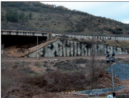
FIGURAS 112 Y 113. VEGETACIÓN EN MURO DE TIERRA REFORZADA O ARMADA (IZQUIERDA) Y ROTURA DE ESTRIBO DE TIERRA REFORZADA O ARMADA (DERECHA).
