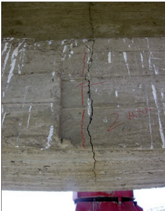
FIGURAS 340 Y 341. LA EXISTENCIA DE FISURAS EN TODOS LOS VANOS, QUE HAN APARECIDO DESDE EL MOMENTO DE LA PUESTA EN SERVICIO Y QUE HAN IDO EVOLUCIONANDO CON EL TIEMPO, HACE PRESUPONER UN FALLO EN EL CÁLCULO ESTRUCTURAL O DE EJECUCIÓN.
