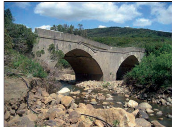
FIGURAS 4.17.1 Y 4.17.2. DESCENSO PARCIAL Y GIRO DE PILA.
