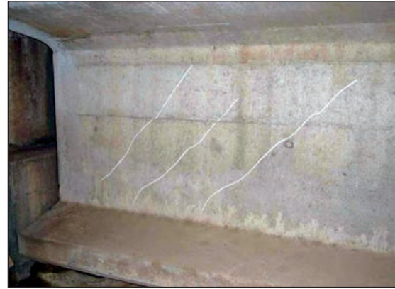
FIGURAS 335 Y 336. FISURACIÓN POR CORTANTE EN VIGA DE HORMIGÓN.
