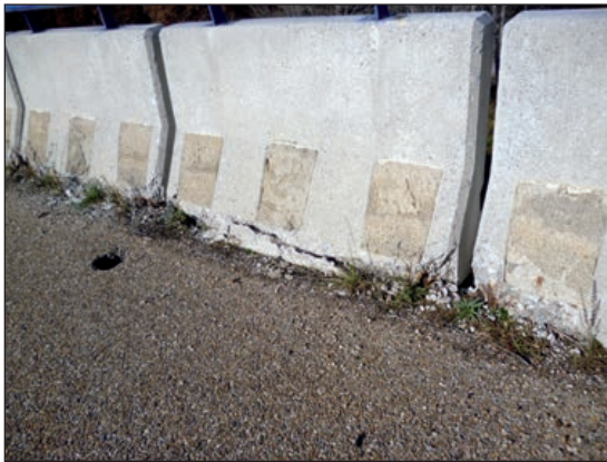
FIGURAS 278, 279, 280, 281. DEGRADACIÓN DEL HORMIGÓN DE UN PRETEL RÍGIDO (FOTO SUPERIOR IZQUIERDA) Y CORROSIÓN DE LA ARMADURA (RESTO DE IMÁGENES) EN ZONA DE INTENSA VIALIDAD INVERNAL.
