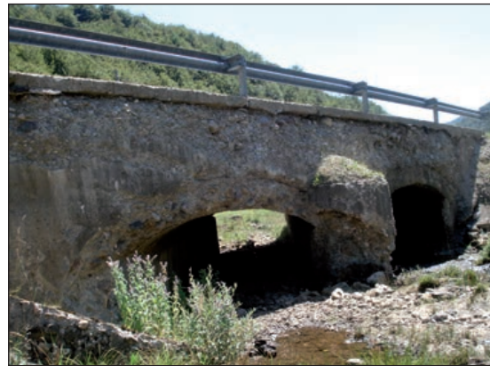
FIGURAS 292 Y 293. DEGRADACIÓN DEL HORMIGÓN EN UNA PILA Y EN UN ESTRIBO POR EFECTO DE HIELO-DESHIELO: ZONAS CON INTENSA VIALIDAD INVERNAL.
