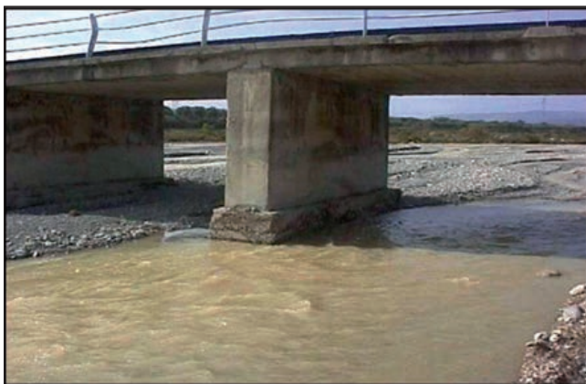
FIGURAS 4.16.1 Y 4.16.2. FORMA DEL FRENTE DE TIPO «PLANO» Y DE TIPO «CIRCULAR».
