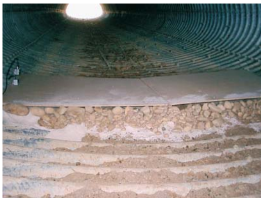
Figuras 4.13. Disposición de la banda de marmolina en un drenaje de chapa corrugada. Fotos: TEG-UAM.
