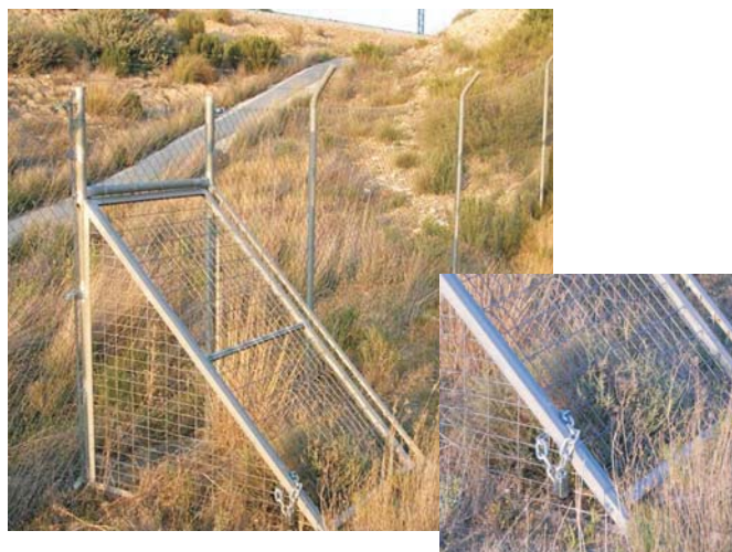
Figura 4.27. Dispositivo de escape bloqueado por un candado, impidiendo su potencial utilización por la fauna. Fotos: TEG-UAM.
