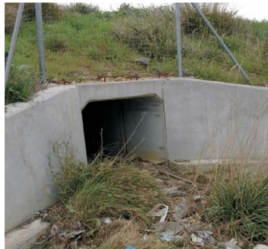
Figura 4.26. Dos aspectos a controlar en los pasos de fauna: mantenimiento de las revegetaciones realizadas (izquierda) y acumulación de escombros en las entradas de pasos para pequeños vertebrados (derecha). En este segundo caso, se trata de residuos arrastrados de la carretera, debido a que el sistema de drenaje de la plataforma se derivó hacia el interior de estas estructuras destinadas al paso de fauna. Fotos: TEG-UAM, Minuartia.
