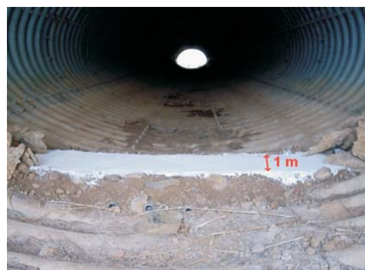
Figuras 4.13. Disposición de la banda de marmolina en un drenaje de chapa corrugada. Fotos: TEG-UAM.
