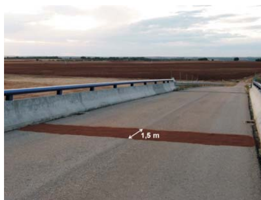
Figura 4.12. Disposición de la banda de control (arena grano fino) en un paso superior multifuncional. Foto: TEG-UAM.
