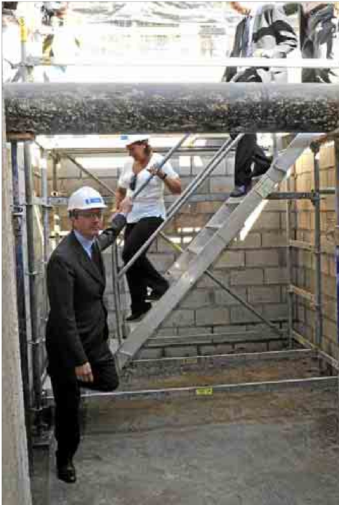
El alcalde de Madrid, Alberto Ruiz-Gallardón, visitando las obras en la calle de General Ricardos. / AYUNTAMIENTO
