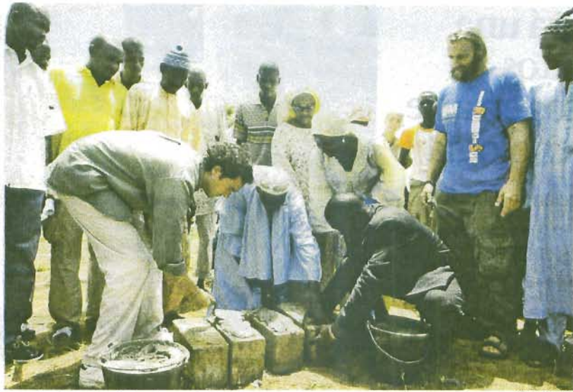
Acto de colocación de la primera piedra de un centro contra la mutilación sexual en Senegal
