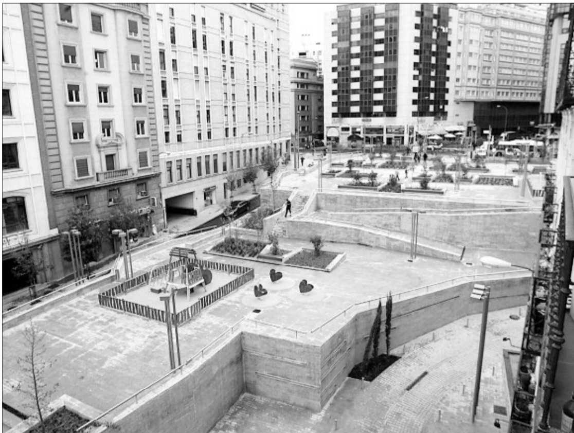
La remodelada plaza de Santo Domingo, vista desde uno de los edificios que la rodean. / LUIS MAGÁN
