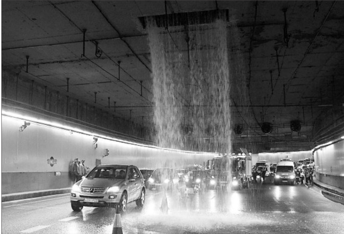
Tramo del túnel inundado el jueves por el agua procedente del colector que sufrió una rotura. / CLAUDIO ÁLVAREZ
