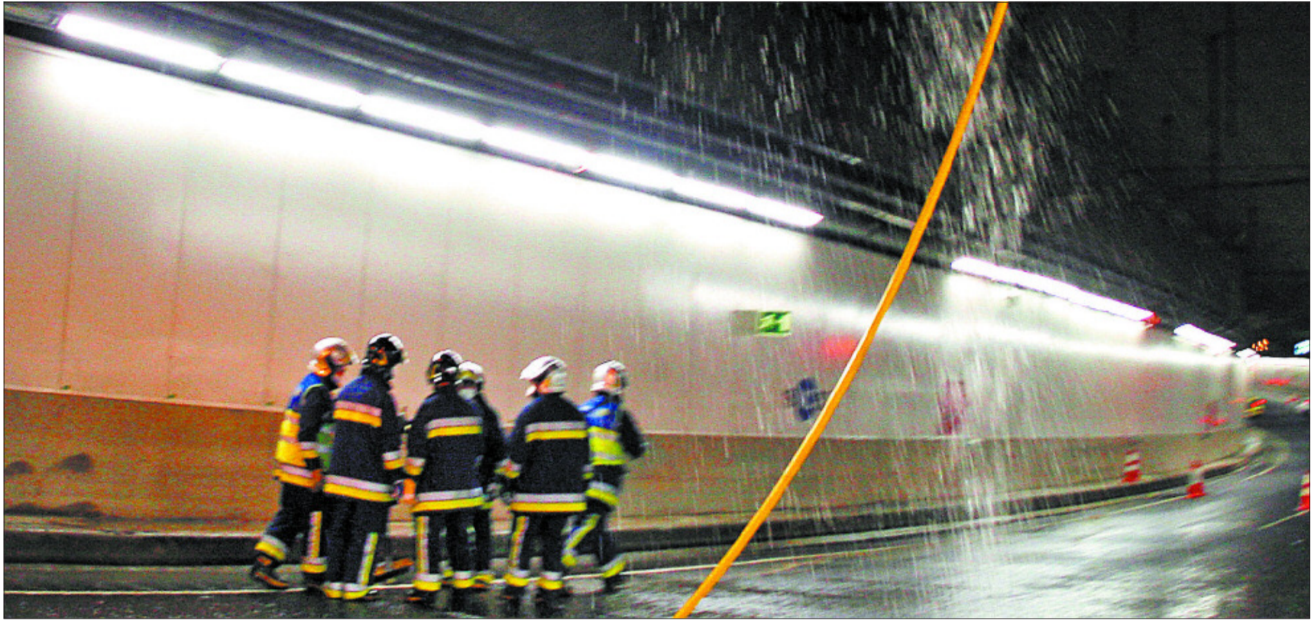
Los bomberos de Madrid Calle 30 trabajan en el interior del túnel inundado. / C. ÁLVAREZ
