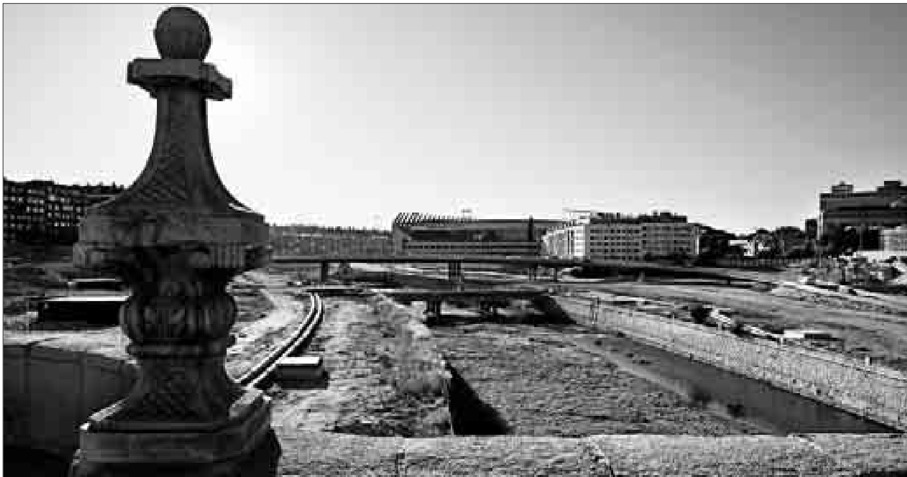
Obras de recuperación de la superficie de la M-30 junto al río Manzanares a la altura del Vicente Calderón. / JAIME VILLANUEVA
