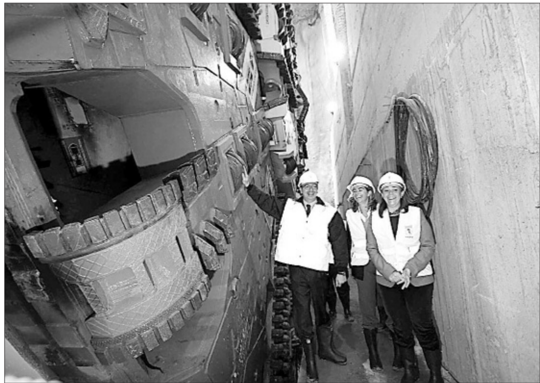
El alcalde, Alberto Ruiz-Gallardón, visita las obras del túnel bypass sur. / SANTI BURGOS
