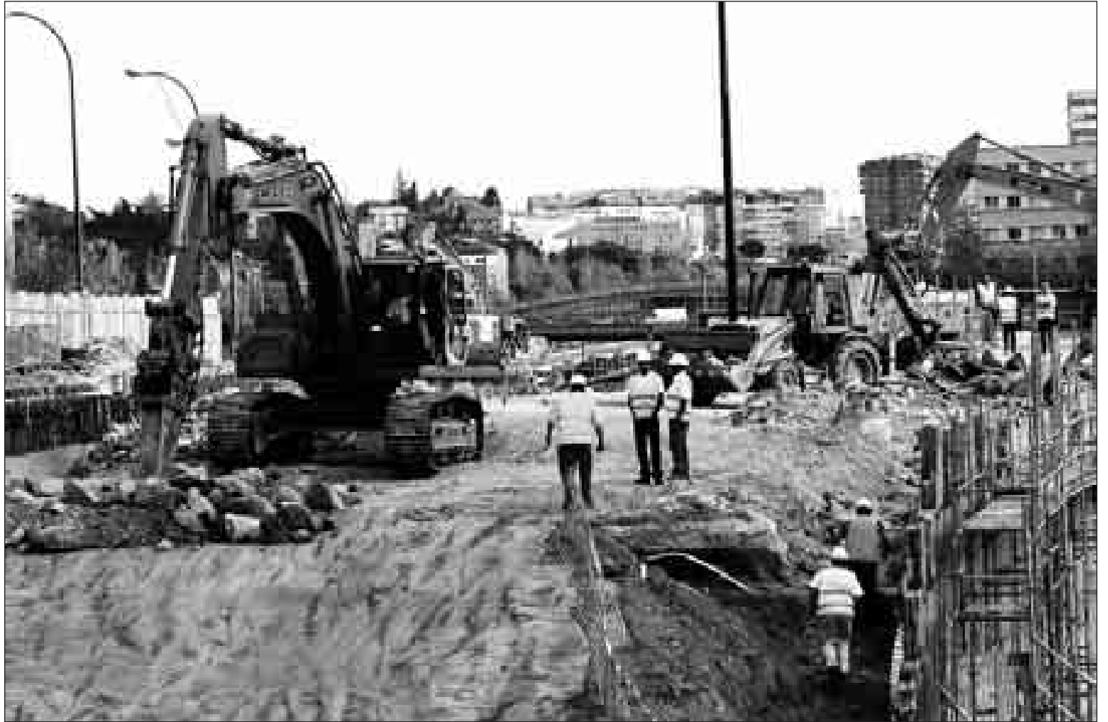
Imagen de las obras de la M-30, en el Nudo de La Paloma. / JOSÉ AYMÁ
