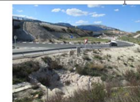
Foto 20. Punto 3. Glorieta ubicada al final del trazado y cercana a las edificaciones afectadas
