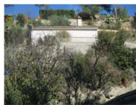
Foto 6: Punto 1. Vista de una de las viviendas afectadas en estado de abandono
